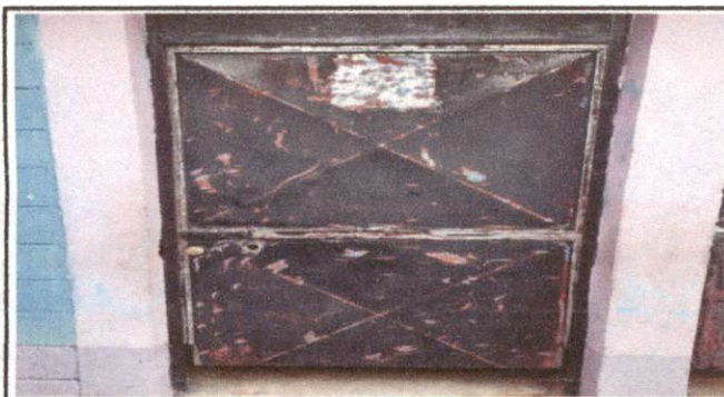
Remodelación de las puertas
