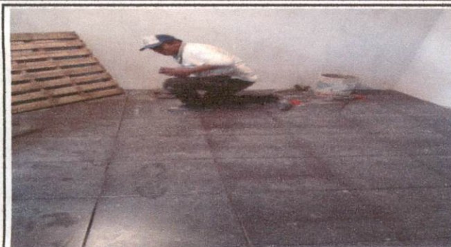
Colocación del piso
