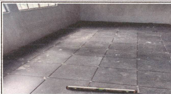
Colocación del piso
