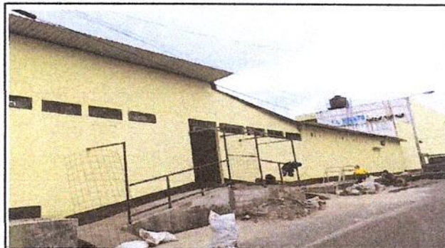
Foto 5: Colocacion de reja y rampa de acceso
