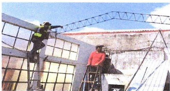
Foto: ESTRUCTURA DE TECHO DE PATIO PRE PRIMARIA
