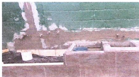
Foto: REMODELACIÓN DE PILA Y DRENAJE
