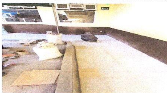
Foto 6: Colocación de piso corredor.
