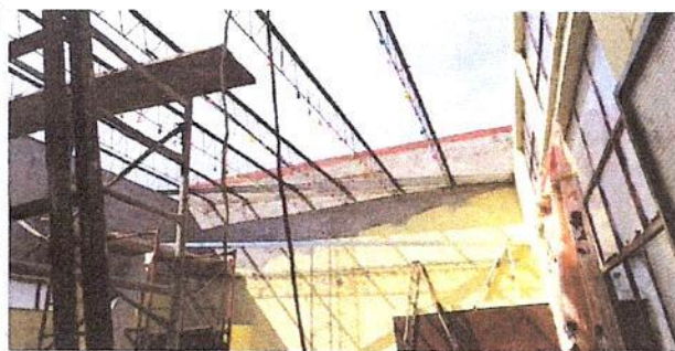
Foto: LEVANTADO DE TECHO 8 HILADAS DE BLOCK
