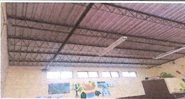
Foto: LEVANTADO DE TECHO 8 HILADAS DE BLOCK
