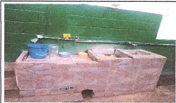
Foto: REMODELACIÓN DE PILA Y DRENAJE
