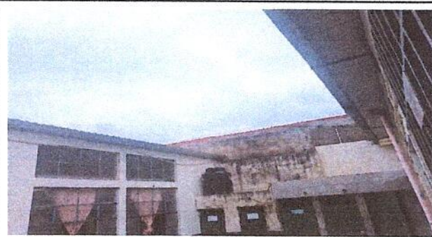
Foto: ESTRUCTURA DE TECHO DE PATIO
