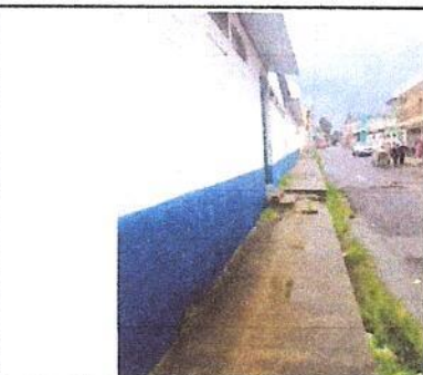
Foto: Colocacion de reja y rampa de acceso
