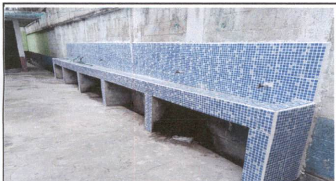
Foto: 3 arreglo de pileta
