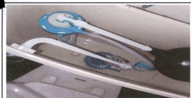
Foto: 5 cambio de sanitarios y accesorios
