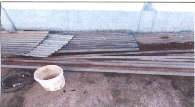
Foto: 3 cambio de lamina
