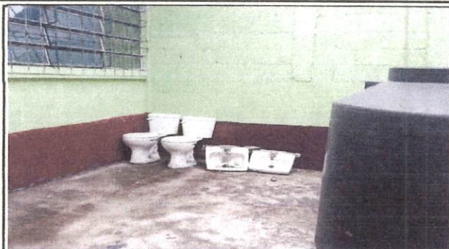
Foto: 2 cambio de sanitarios
