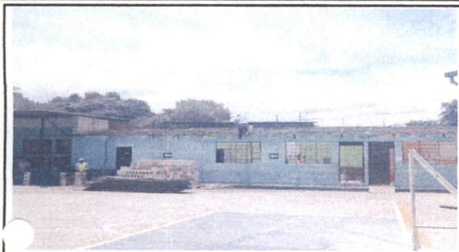
Foto: 1 cambio de techo
