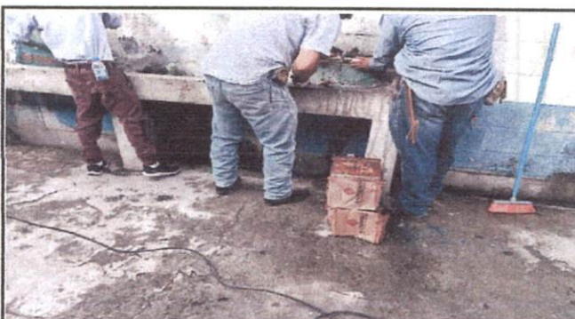
Foto: 4 colocación de azulejo en pileta
