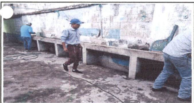
Foto: 5 arreglo de tubería y azulejo
