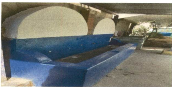
Foto 5 Pileta ya remozada se hizo cernido
