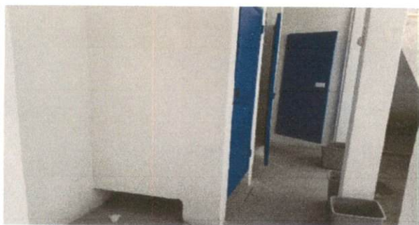
Foto 3 se elimino pared y reforzo columnas
