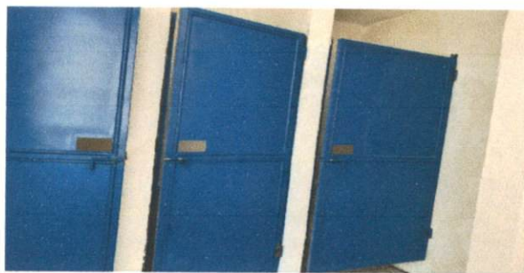
Foto: 4 Los baños cuentan con su puerta
