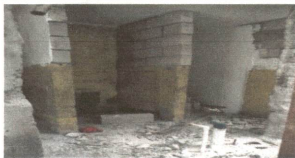
Foto 2: Eliminación de paredes de baño y construcción de complemento de
