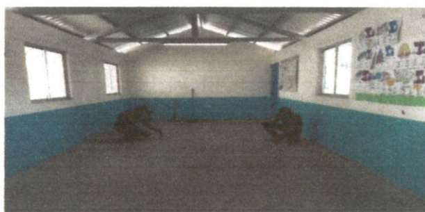
Foto 4: Pintura de estructura
