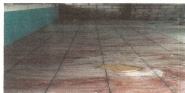
Foto 5: Construcción de pared de división y colocación de piso
