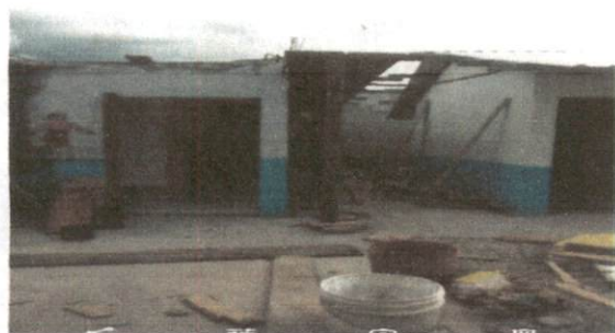
Foto 1: Arreglo de techo de baño
