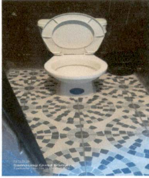
Foto1: se instalo piso en los sanitarios
