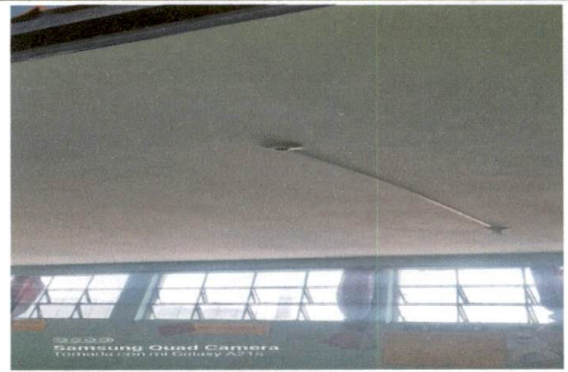
Foto 4: istalando el cielo falso en 5 aulas
