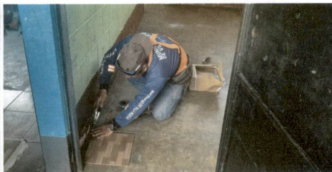
Foto 5: aulas de primaria con piso de cemento
