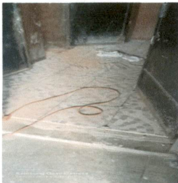
Foto 1: piso de sanitarios
