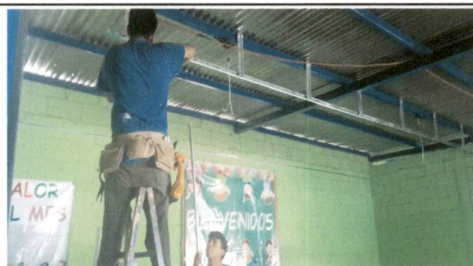
Foto 4: instalando estructura para cielo falso con tabla yeso
