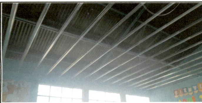
Foto 3: estructura para cielo falso
