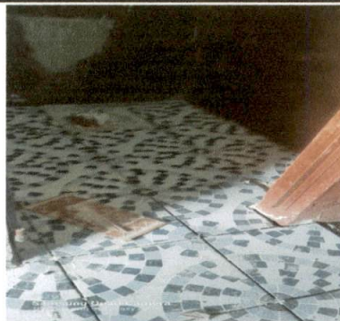
Foto 2: cambio de sanitarios e instalacion de piso
