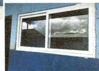
Foto 6: Cambio de ventanas de marco de metal que estaban selladas por ventanas de PVC.
