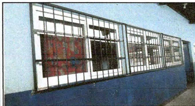
Foto 3: Elaboración e instalación de balcones de metal
