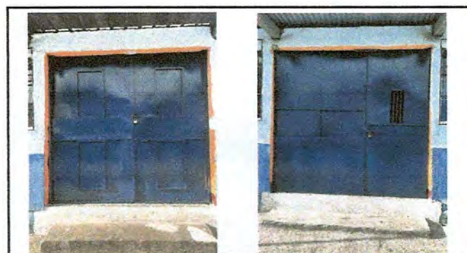
Foto 6: Reparación y pintura de portones
