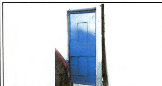
Foto 5: Reparación y pintura de puertas
