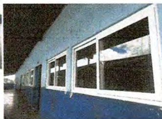
Foto 5: Cambio de ventanas de marco de metal que estaban selladas por ventanas de PVC.
