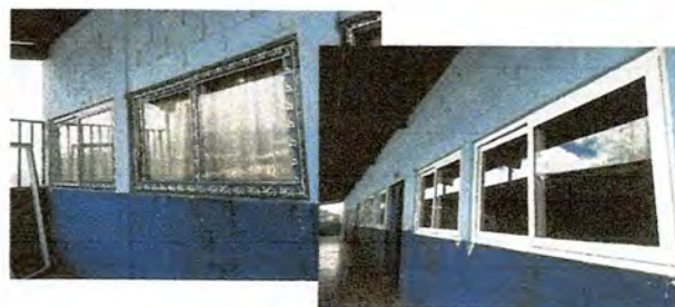
Foto 2: Instalación de Ventanas de PVC
