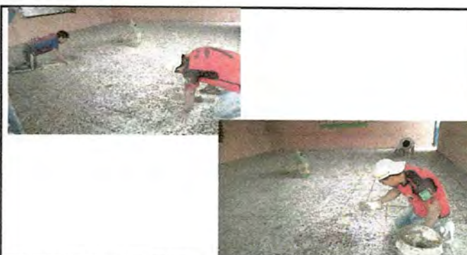
Foto 6: Llenado de juntas con cemento.
