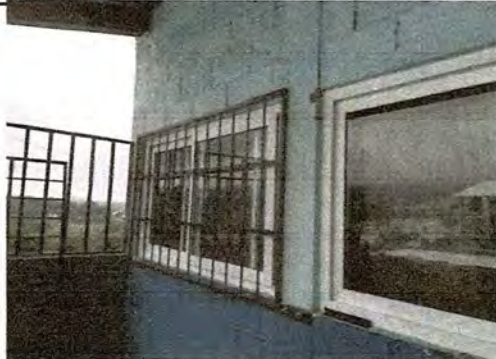
Foto 2: Elaboración e instalación de balcones de metal
