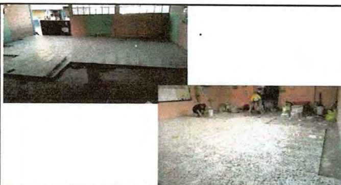
Foto 5: Inicio de colocación de piso de granito.
