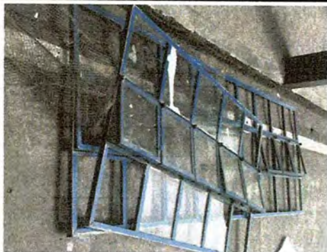
Foto1: Desmontaje de ventanería de hierro.
