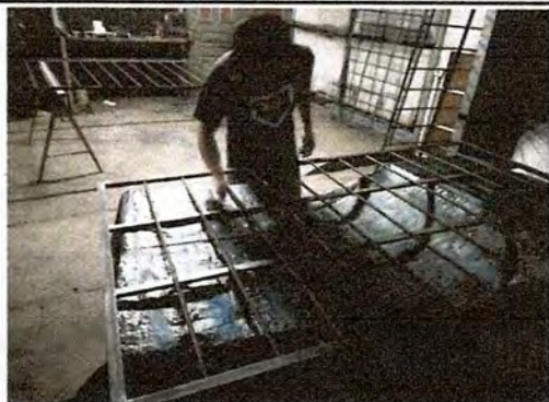
Foto1: Elaboración e instalación de balcones de metal
