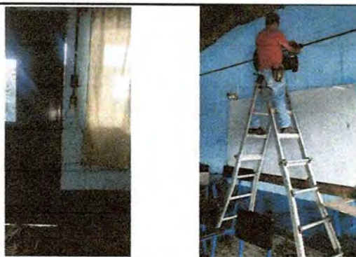
Foto 3: Retiro de cableado viejo e instalación de tubería y cableado nuevo.
