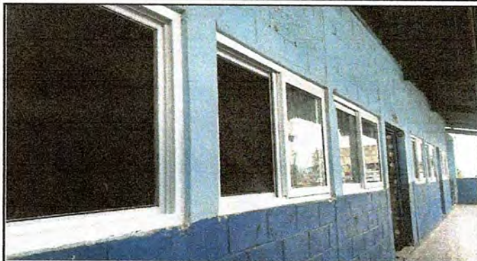
Foto1: Elaboración e instalación de balcones de metal
