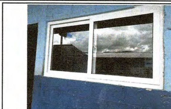
Foto 2: Elaboración e instalación de balcones de metal
