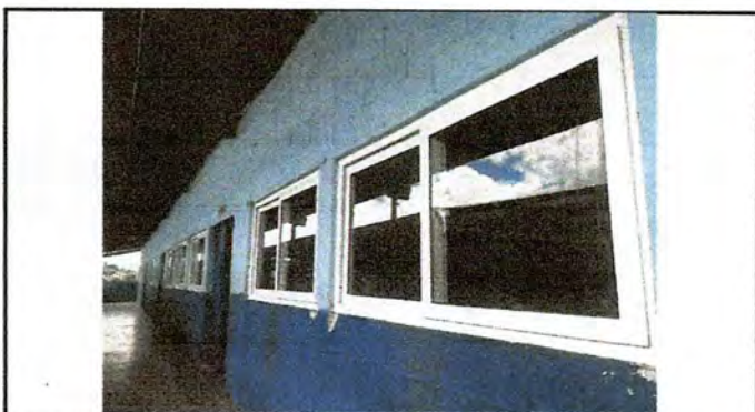
Foto 3: Elaboración e instalación de balcones de metal
