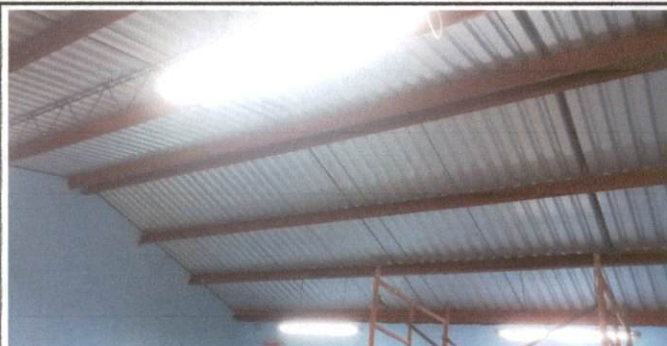
Foto 2: Vista de la estructura metálica sobre la que se colocó la lámina aluzinc en área de cocina.
