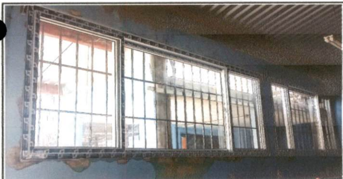
Foto 11: Instalación de ventana PVC en área de cocina.
