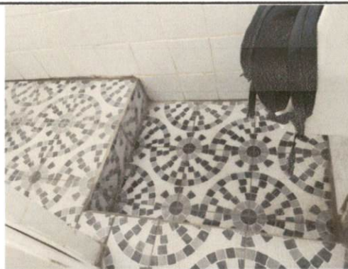
Foto 22: Colocación de nuevo piso en el sanitario del segundo nivel del salón de maestros.
