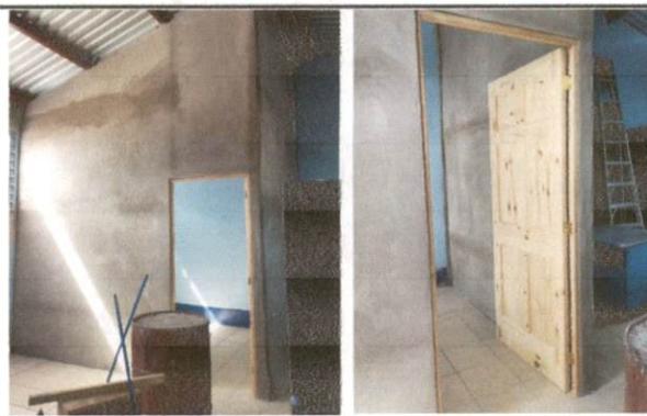
Foto 16: Espacio de almacenamiento (bodega) con sus elementos estructurales y puerta.
