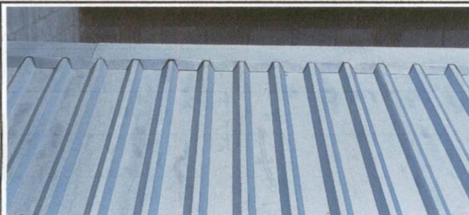
Foto 1: Instalación de lámina aluzinc en techo de cocina.
