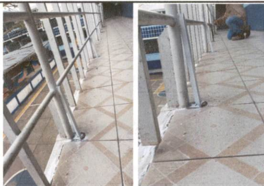
Foto 28: Instalación de dos refuerzos en la baranda del segundo nivel.
