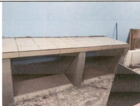
Foto 23: Extremo más largo de la mesa fundida con sus cargadores y azulejos.
