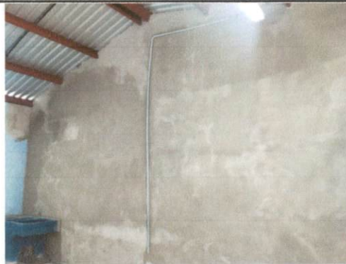
Foto 14: Aplicación de nuevo cernido en pared del área de cocina.
