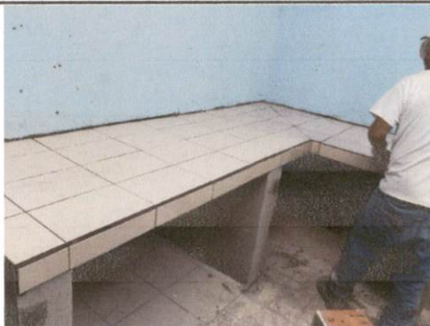
Foto 24: Extremo más corto de la mesa fundida con sus cargadores y azulejos en el área de cocina.
