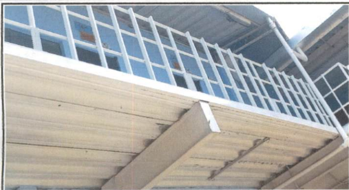
Foto 7: Sustrucción de cenefa o parte frontal de costanera que se enoctraba oxidada.
