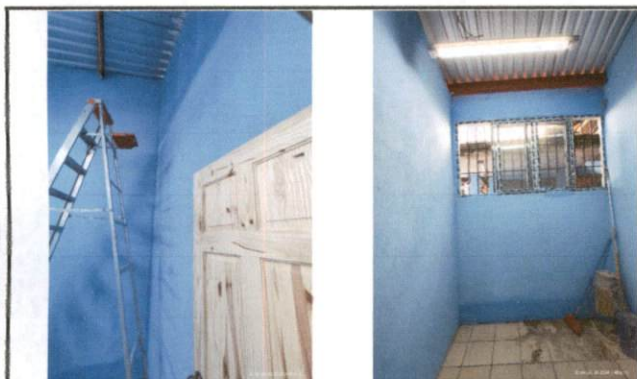
Foto 33: Pintura en bodega de cocina.
