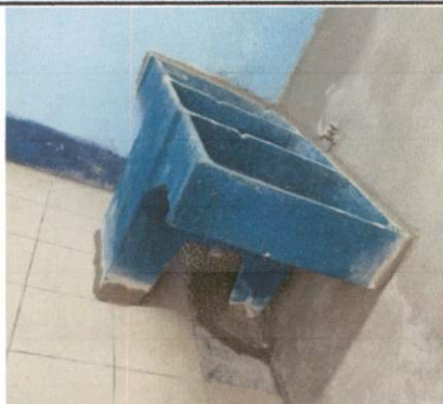
Foto 13: Habilitación de pila existente en cocina.
