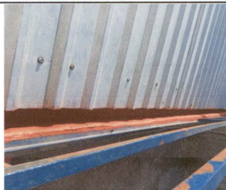
Foto 26: Impermeabilización del canal de concreto en el techo del área de la cocina (otro extremo).
