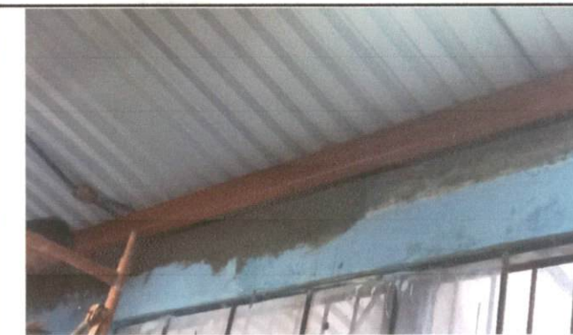
Foto 10: Sellado de parte superior del área de cocina.
