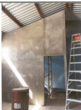
Foto 15: Construcción de espacio de almacenamiento (bodega) en área de cocina.
