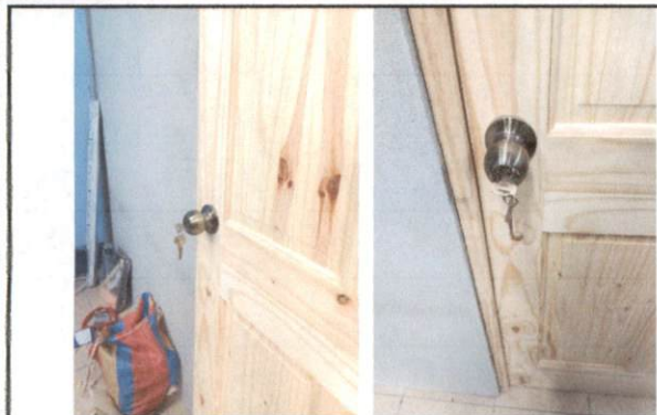
Foto 31: Colocación de chapa en puerta de la bodega de cocina.
