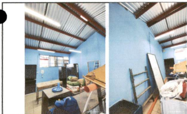
Foto 35: Pintura general en el área de cocina.
