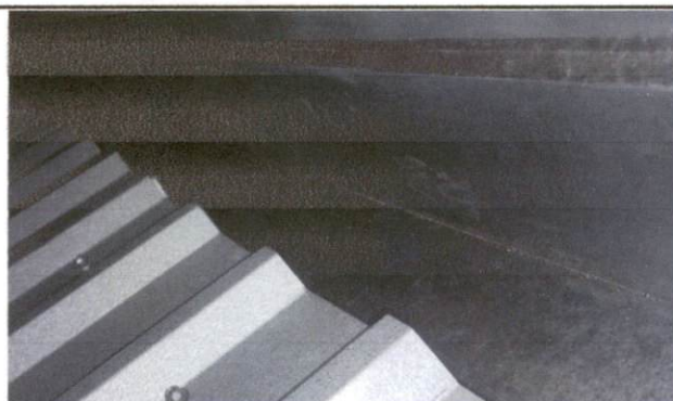
Foto 4: Instalación de cana PAP en techo de cocina.
