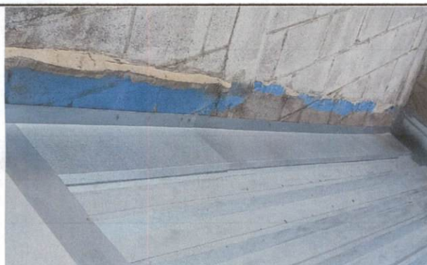
Foto 3: Instalación de botaguas y sellado en el techo de cocina.
