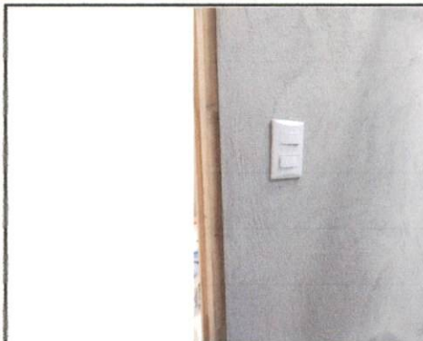
Foto 32: Instalación de interruptor independiente en la bodega de la cocina.
