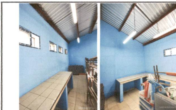
Foto 34: Pintura general en el área de cocina.
