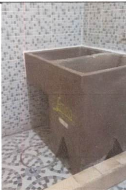
Foto 27: Habilitación de pila existente en el sanitario del primer nivel del salón de maestros.
