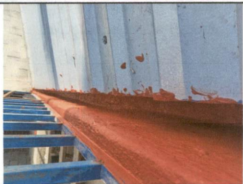
Foto 25: Impermeabilización del canal de concreto en el techo del área de la cocina (un extremo).
