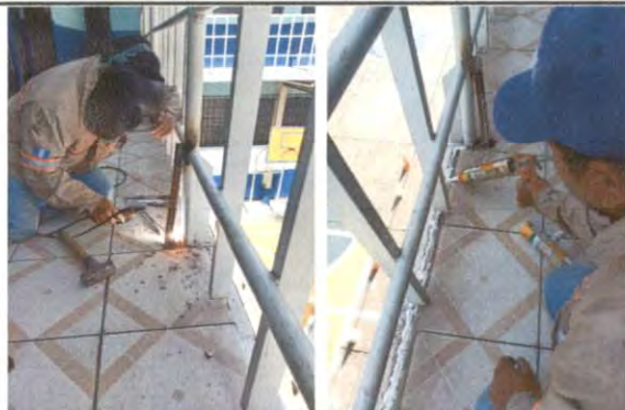
Foto 28: Soldadura de dos refuerzos en baranda del segundo nivel para evitar que se mueva y sellado con sikaflex en la orilla entre costanera y terraza.
