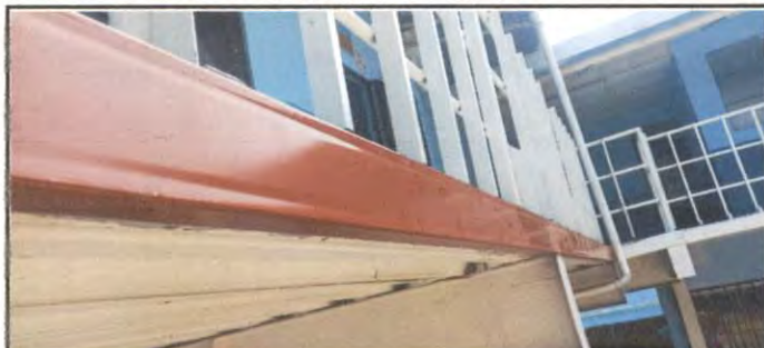
Foto 8: Instalación de parte frontal de costanera con pintura antioxidante.
