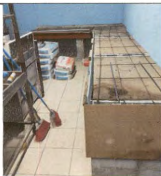
Foto 17: Estructura metalica de la mesa fundida (extremo más largo) en el área de cocina.
