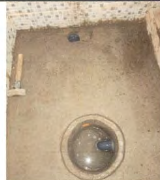
Foto 20: Recuperación de reposadera en el área de pila en el salón de maestros del primer nivel y elaboración de sifon para evitar malos olores.
