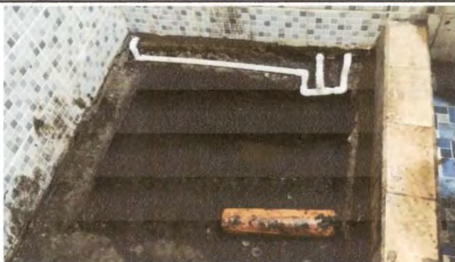
Foto 19: Desprendimiento de piso para corregir conexiones de tubería de drenaje en el área de pila del primer nivel del salón de maestros.
