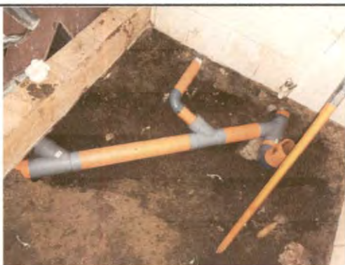
Foto 21: Cambio de toda la tubería que conecta sanitario del segundo nivel con sanitario del primer nivel del salón de maestros.
