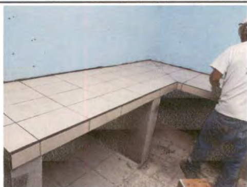
Foto 27: Instalación de azulejo en toda la parte superior de la mesa fundida en el área de cocina.
