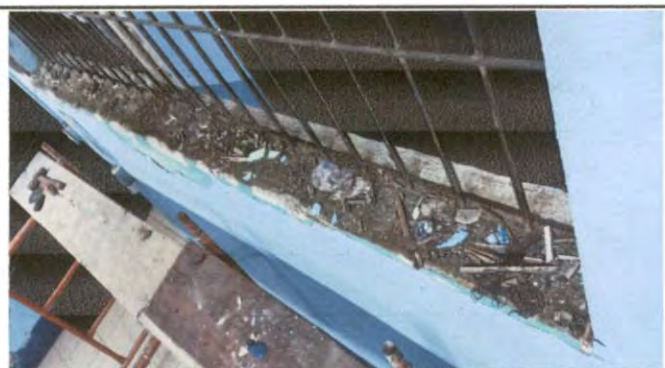
Foto 11: Remoción de ventanas antiguas y limpieza del área.
