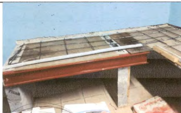
Foto 18: Estructura metalica de la mesa fundida (extremo más corto) en el área de cocina.
