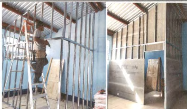
Foto 15: Instalación de postes galvanizados para formar la estructura de almacenamiento
