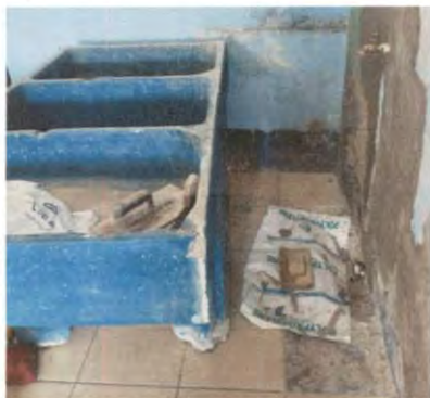
Foto 13: Remoción de pila en el área de cocina para corregir problema de malos olores.
