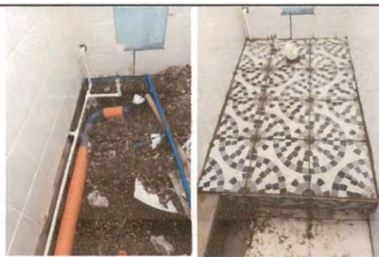
Foto 24: Colocación de piso previo a la instalación del inodoro en el sanitario del segundo nivel del salón de maestros.
