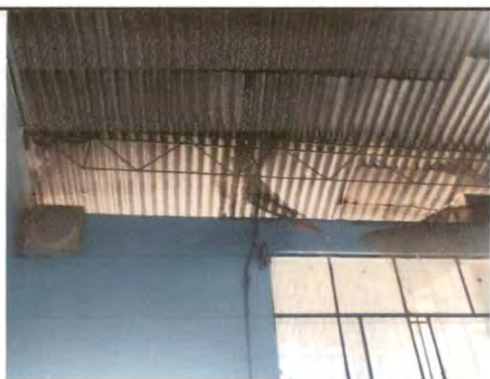
Foto 3: Limpieza de aberturas en el área de cocina.
