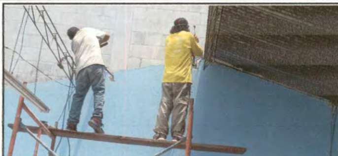
Foto 1: Remoción de lámina y estructura metálica.
