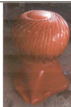
Foto 10: Aplicación de anticorrosivo al extractor de olores del área de cocina.
