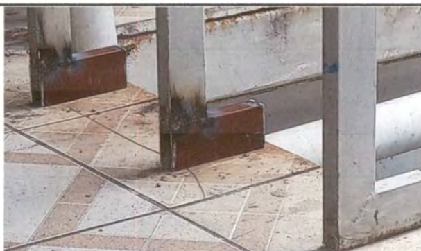
Foto 5: Cambio de piezas de metal oxidadas por nuevas.
