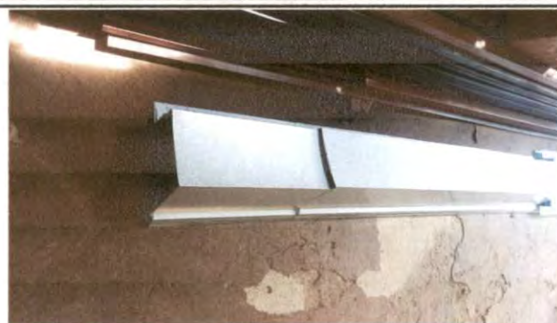
Foto 2: Elaboración de nuevo canal para el área de cocina.
