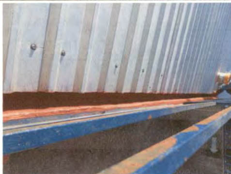
Foto 26: Aplicación de impermeabilizante en canal de concreto del techo del área de cocina.
