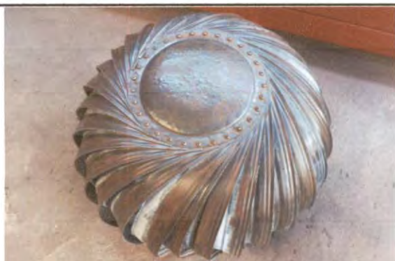
Foto 9: Limpieza de extractor de olores del techo del área de cocina.
