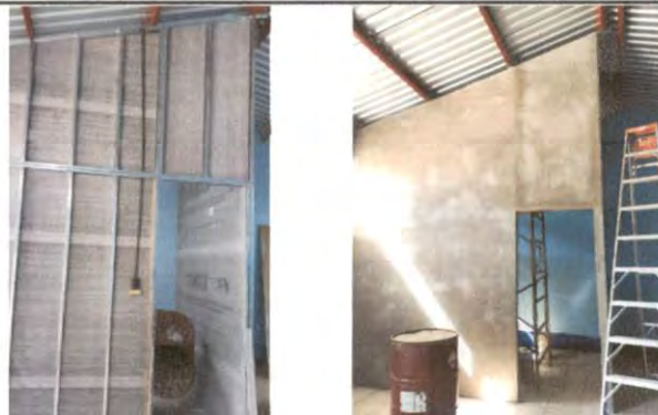
Foto 16: Instalación de tabla rocka y apagador independiente. Aplicación de cernido en la estructura de almacenamiento.
