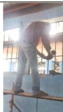
Foto 12: Limpieza de balcón existente con presencia de oxidación.
