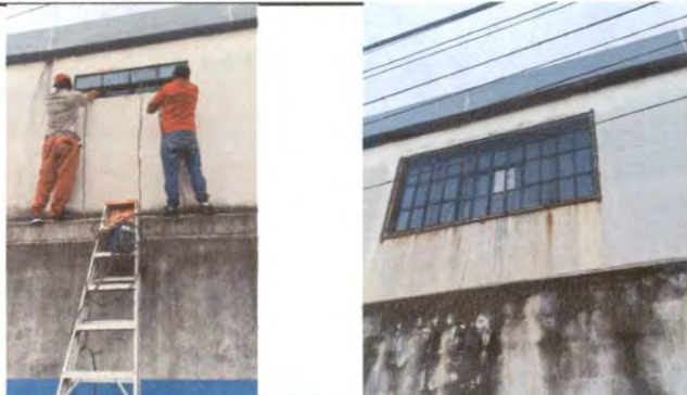
Foto 30: Colocación de lámina desplegada en dos ventanas que dan a la 13 avenida.
