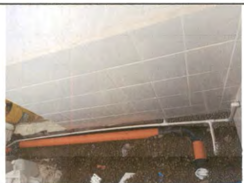
Foto 23: Cambio completo de la tubería en el sanitario del segundo nivel del salón de maestros.
