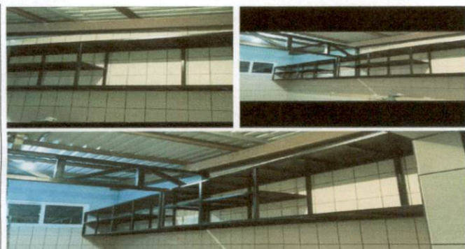
Foto 3. MUEBLE DE METAL PARA LA COCINA Y BIGA PARA DETENER EL TECHO TERMINADA
