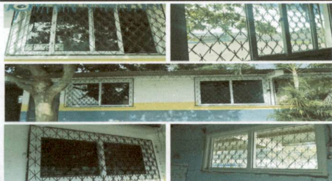
Foto1: VENTANAS DE PVC COLOCADAS EN LAS AULAS
