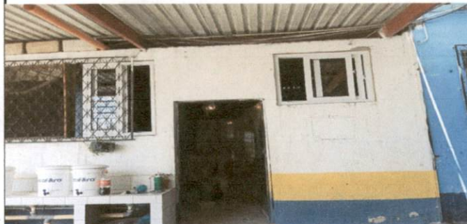
Foto 2: AMPLIACIÓN DE VENTANAS Y COLOCACIÓN DE VENTANAS DE PVC
