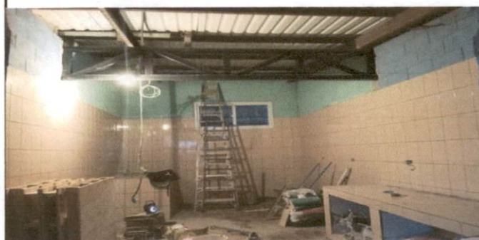
Foto 4: TRABAJO DE ELECTRICIDAD Y COLOCACIÓN DE AZULEJO
