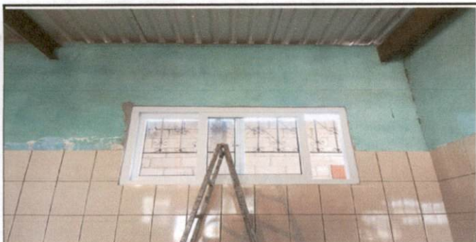
Foto 5: AMPLIACIÓN DE VENTANA TRASERA Y COLOCACIÓN DE VENTANA PVC
