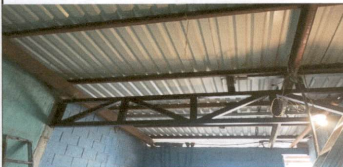
Foto 1: COLOCACIÓN DE BIGA PARA DETENER EL TECHO DONDE SE ENCUENTRA EL TINACO DE AGUA
