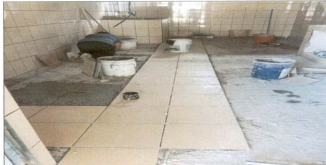
Foto 6: COLOCACIÓN DE PISO
