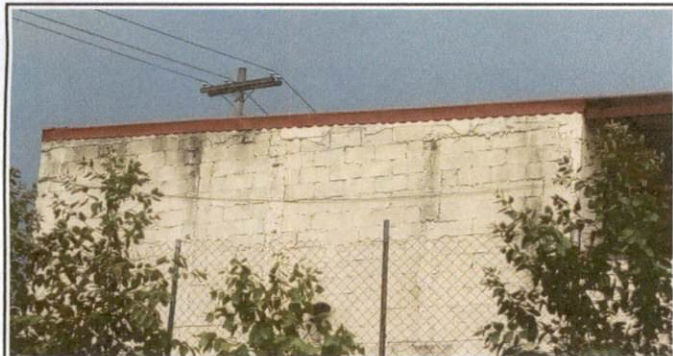
Foto 3: Instalación de capote en todo el techado.
