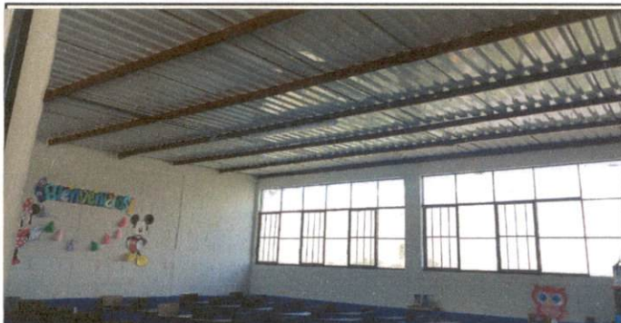
Foto 4: Sustitución de láminas acanaladas por láminas troqueladas prepintadas calibre 26.
