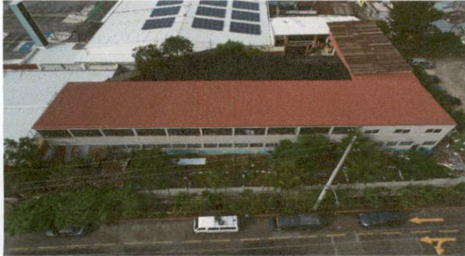
Foto 1: Sustitución de láminas acanaladas por láminas troqueladas prepintadas calibre 26.
