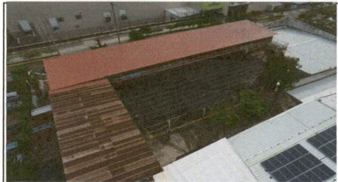
Foto 2: Sustitución de láminas acanaladas por láminas troqueladas prepintadas calibre 26.
