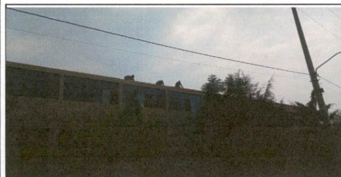
Foto 5: Instalación de capote en todo el techo.
