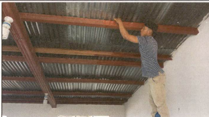
Foto 2: Mantenimiento a estructura portante: Aplicación de pintura anticorrosiva.
