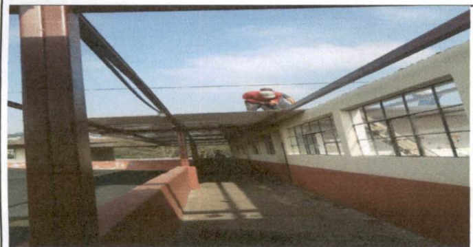
Foto 3: Desmontaje y cambio de láminas.
