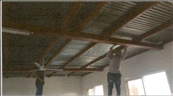
Foto 1: .Mantenimiento a estructura portante: Lijado y cepillado
