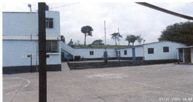
Foto 4: MODULO DE AULAS REHABILITADAS .
