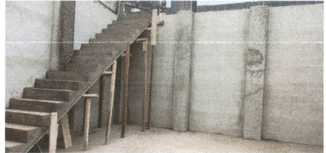
Foto 2: TERMINACION DE MURO DE CONTENCIÓN
