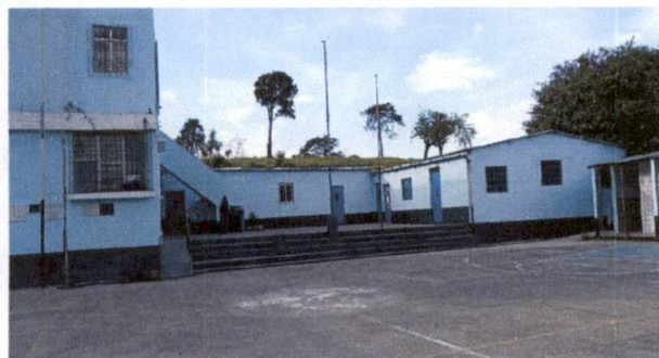
Foto 3: MODULO DE AULAS REHABILITADAS
