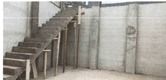
Foto 4: TERMINACION DE TORTA CEMENTO .
