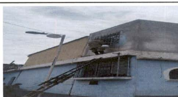
Foto 5: ESPACIOS DE PAREDES A REHABILITAR
