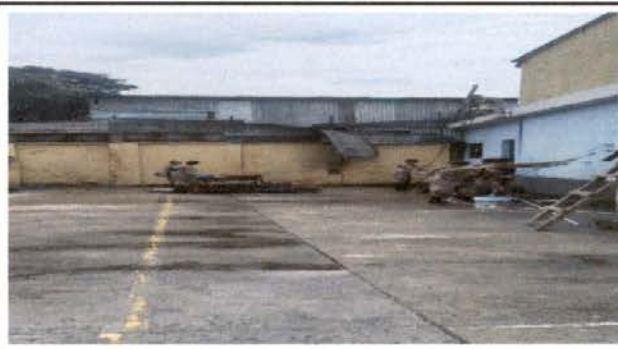
Foto 2: ESPACIO DE CANCHA A REHABILITAR
