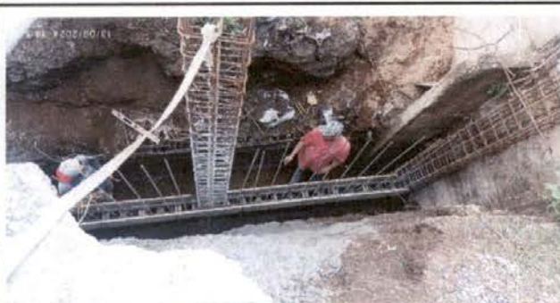
Foto 5: LEVANTADO DE MURO DE CONTENCIÓN , PINIADO
