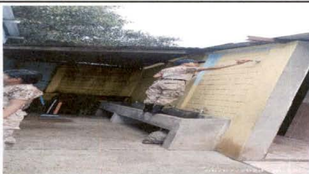
Foto1: ESPACIO DE LAVAMANOS A REHABILITAR
