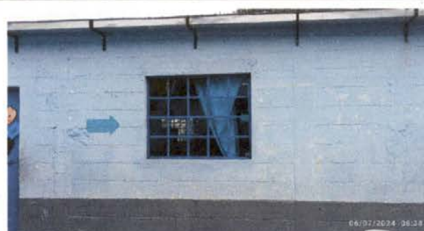
Foto 4: PARED DE SALON A REHABILITAR .
