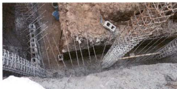
Foto 4: LEVANTADO DE MURO DE CONTENCIÓN
