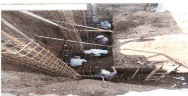
Foto 3: LEVANTADO DE COLUMNAS .
