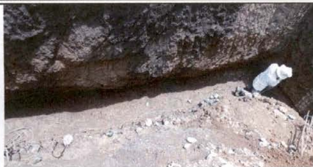
Foto 1: PROFUNDIDAD DE ZANJEOS .
