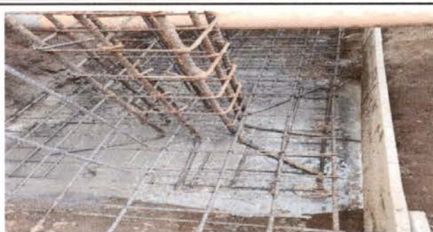
Foto 2: CONSTRUCCION DE CIMIENTO .
