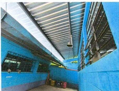
Foto 5: Cambio de Lámina de pasillo
