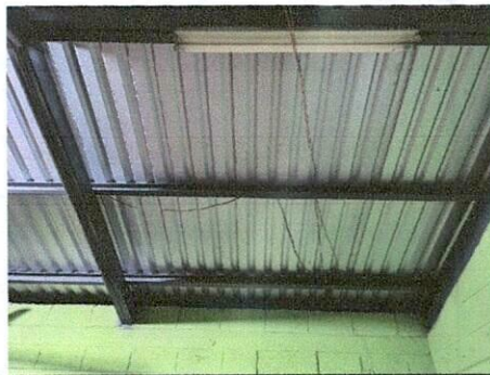
Foto 6: Cambio de Lámina
