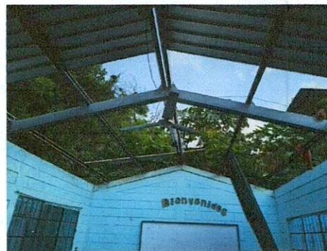
Foto 4: Cambio de lámina
