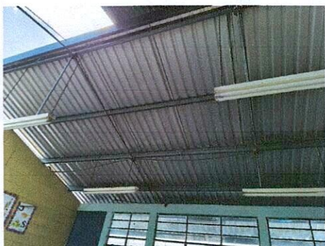
Foto 3: Cambio de Lámina
