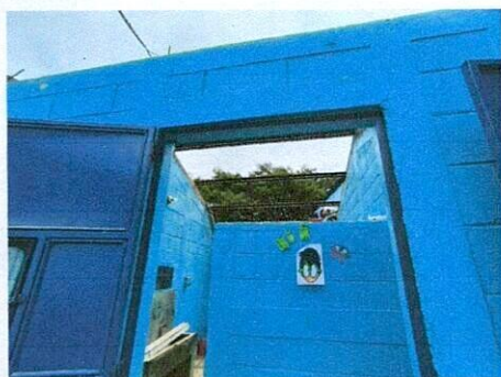
Foto 5: Cambio de lámina en baños
