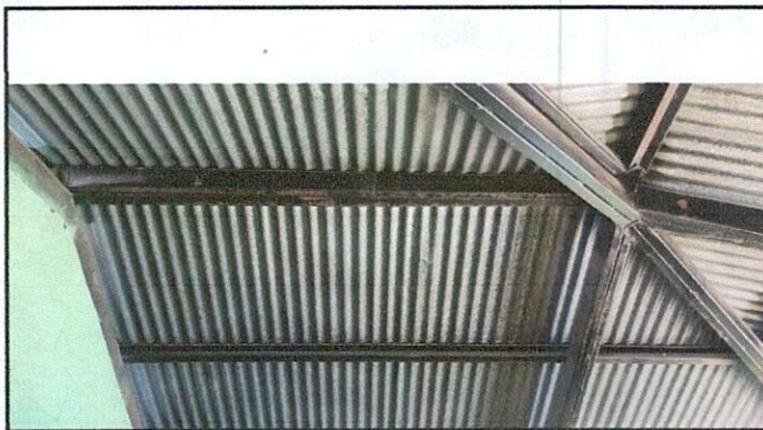
Foto 4: Cambio de láminas
