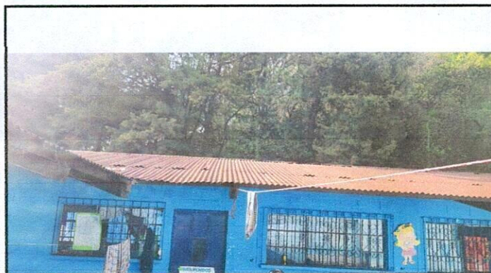
Foto 3: Techado de aulas
