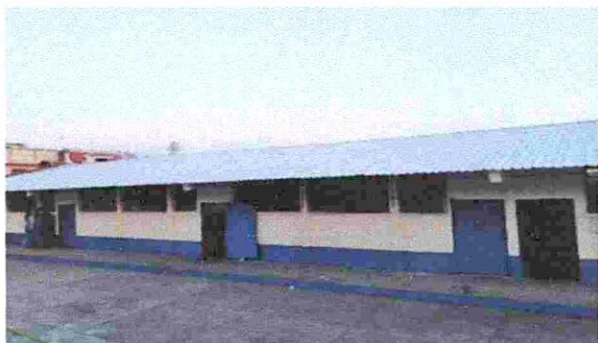
Foto: CAMBIO DE TECHO
