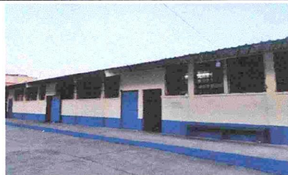
Foto: 2 CAMBIO DE TECHO
