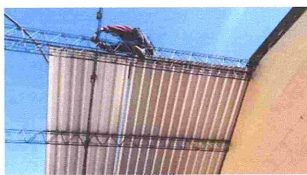
Foto: 2 CAMBIO DE TECHO
