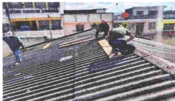
Foto: CAMBIO DE TECHO
