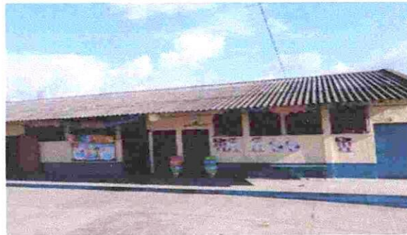
Foto: 2 CAMBIO DE TECHO
