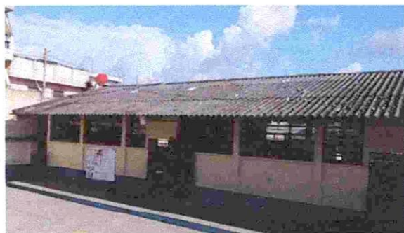
Foto: CAMBIO DE TECHO
