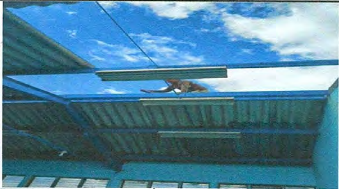
MANTENIMEINTO PINTURA TRES MANOS AZUL BANDERA, LUEGO DE LIJAR ESTRUCTURA METALICA
