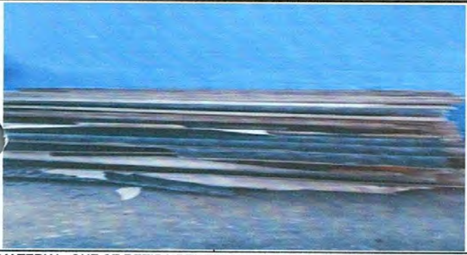
MATERIAL QUE SE RETIRA DEL TECHO, DURALITA INSERVIBLE
