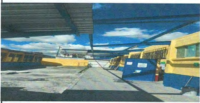
MANTENIMEINTO DE ESTRUCTURA METALICA
