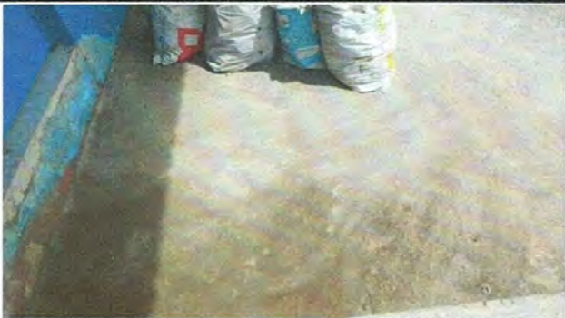
AREA PREPARADA Y COMPACTADA PARA RAMPA Y CORREDOR
