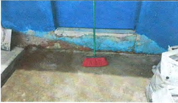
INIAN A PREPARAR EL AREA DE FUNDICION PARA RAMPA
