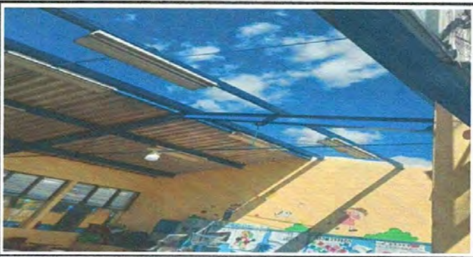
COLOCACION DE TECHO EN SALONES DE CLASE
