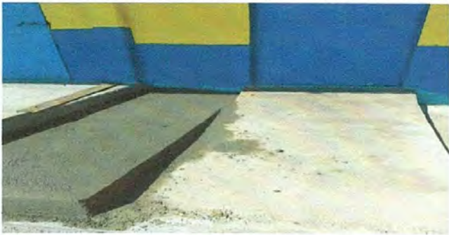
TRABAJOS EN PROCESO DE RAMPA Y CORREDOR
