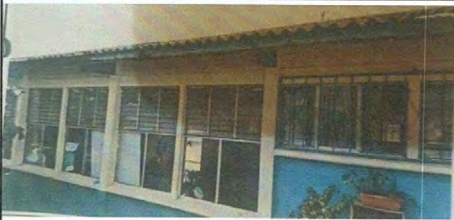
CAMBIO DE TECHO DURALITA POR TROQUELADA ALUZINC
