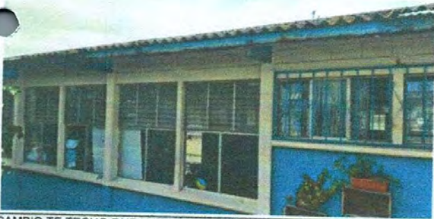
CAMBIO TE TECHO DURALITA POR TROQUELADA DE ALUZIN
