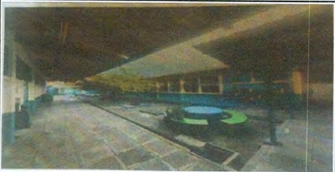
CAMBIO DE TECHO DURALITA POR TROQUELADA ALUZINC
