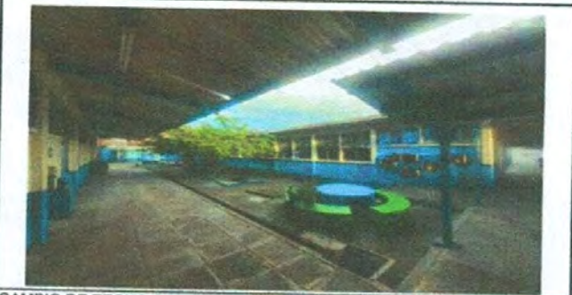
CAMBIO DE TECHO DURALITA POR TROQUELADA ALUZIN
