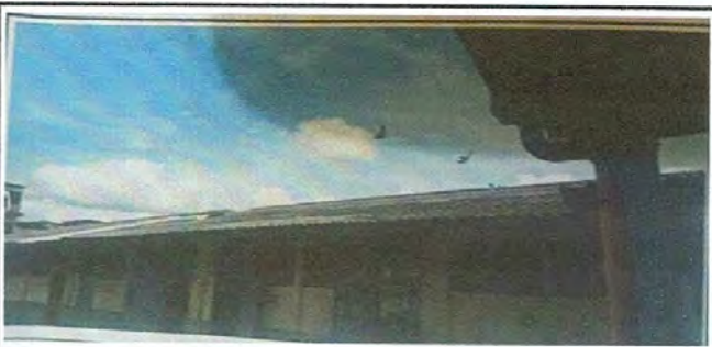
CAMBIO DE TECHO DURALITA POR TROQUELADA ALUZINC
