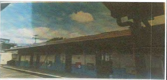
CAMBIO DE TECHO DURALITA POR TROQUELADA ALUZINC
