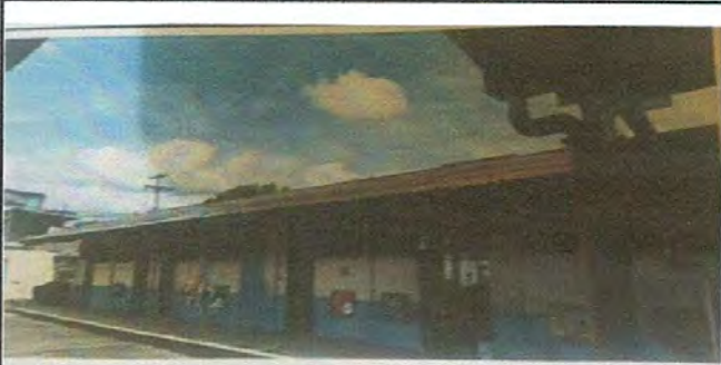
CAMBIO DE TECHO DURALITA POR TROQUELADA ALUZINC
