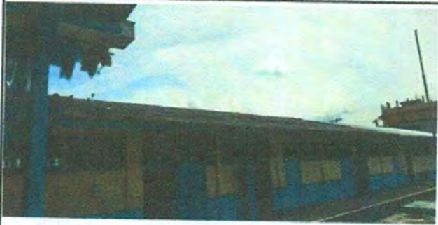
CAMBIO DE TECHO DURALITA POR TROQUELADA DE ALUZIN
