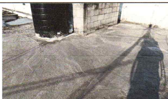
Foto 6: Aplicación de mezcón nuevo en una parte de la terraza del lado derecho
