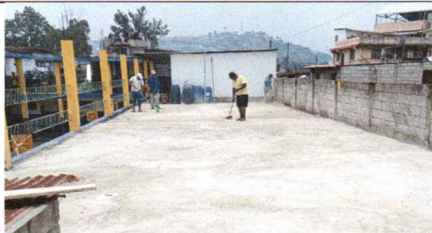
Foto 12: Limpieza de losa previo a aplicación de impermeabilizante en terraza del lado izquierdo
