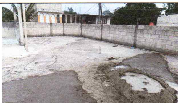
Foto 5: Mezcla de materiales que permitirá la realización de pañuelos en losa de la terraza del lado derecho
