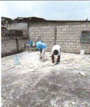
Foto 9: Personal levantando mezlón con barreta en terraza del lado derecho
