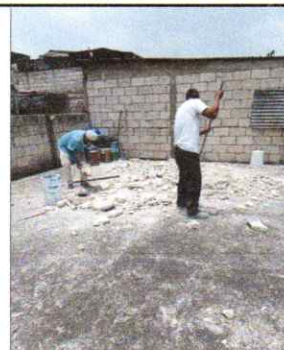
Foto 4: Personal trabajando para levantar el mezcón en mal estado de la terraza del lado derecho
