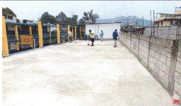
Foto 10: Limpieza de losa previo a aplicación de impermeabilizante en terraza del lado izquierdo
