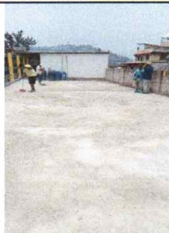
Foto 11: Cuadrilla limpiando losa previo a la aplicación de impermeabilizante, en el lado izquierdo
