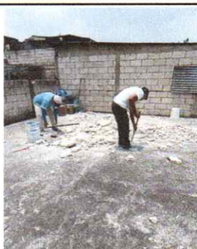
Foto 3: Personal trabajando para levantar el mezcón en mal estado de la terraza del lado derecho
