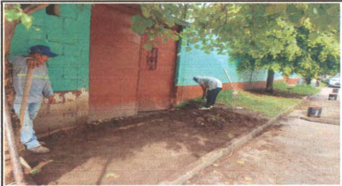
Foto 4: inicio de trabajos de la banqueta de la escuela
