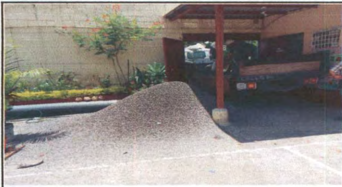
Foto1: ingreso de los materiales de construccion
