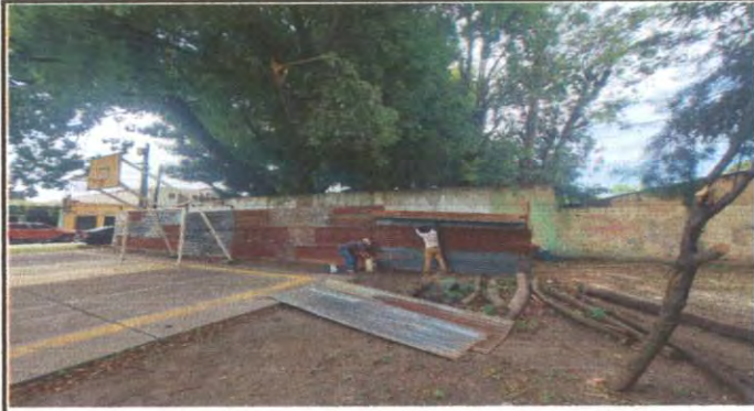
Foto 4: colocacion de cerco para proteccion antes del inicio de los trabajos
