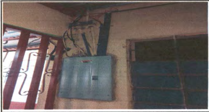
Foto 6: colocacion de caja de electricidad
