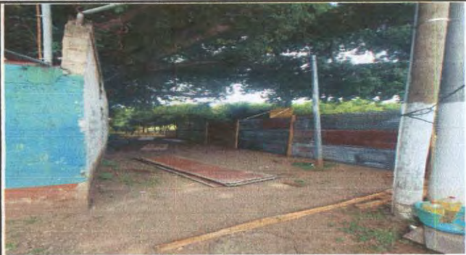
Foto 1: colocacion de cerco para proteccion antes del inicio de los trabajos
