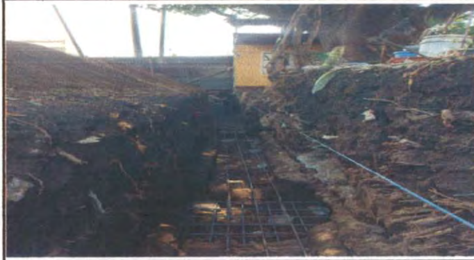
Foto 4: hierro de la zapata
