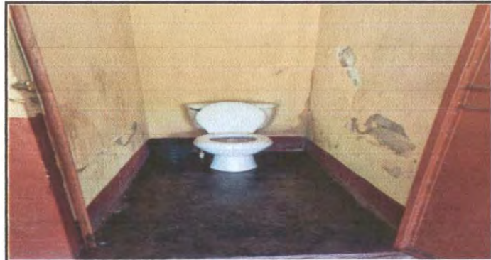
Foto 6: cambio de sanitario grande, colocacion de un sanitario pequeño para niños de kinder y prepa.
