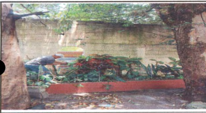
Foto 5: inicio de la demolicion de la pared en mal estado
