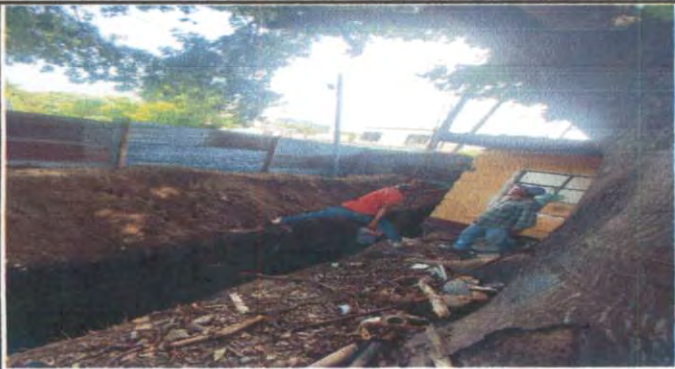
Foto1: colocacion de la zapata
