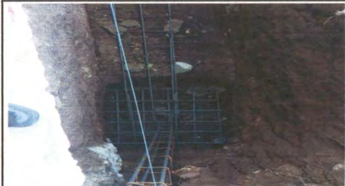
Foto 2: colocacion de cimientos.
