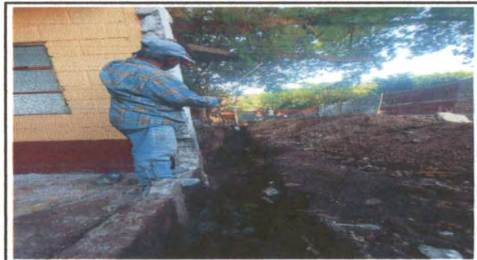
Foto 4: realizacion de la zanja
