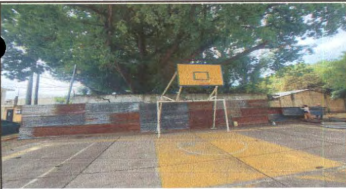
Foto 3: colocacion de cerco para proteccion antes del inicio de los trabajos
