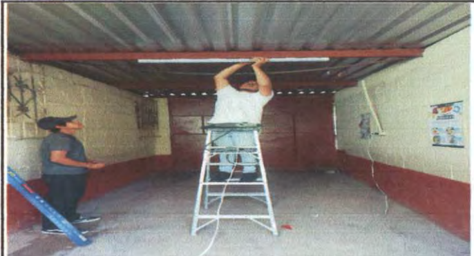
Foto 2: instalacion de lamparas
