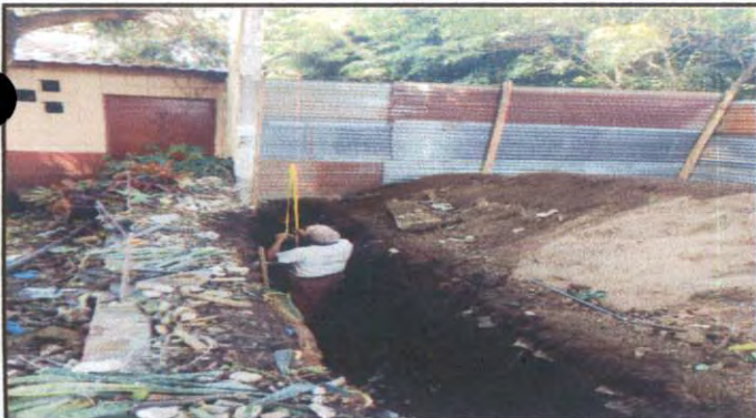
Foto 3: realizacion de la zanja
