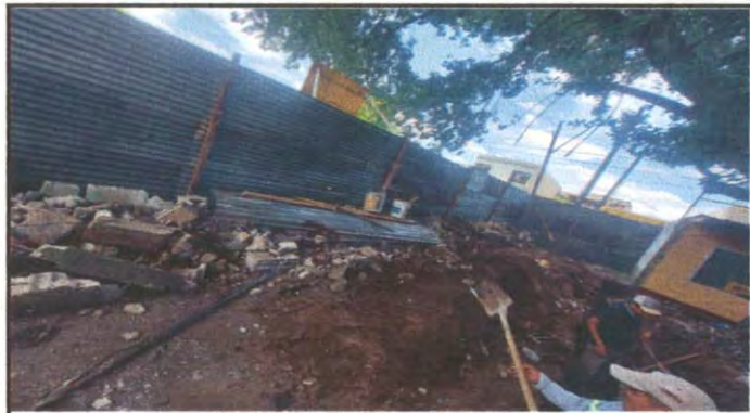
Foto 2: realizacion de la zanja
