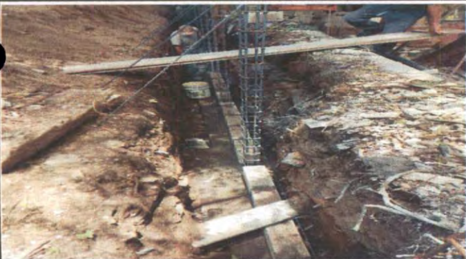
Foto 3: fundicion de zapata y levantado
