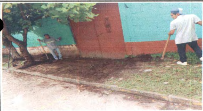
Foto 3: inicio de trabajos de la banqueta de la escuela
