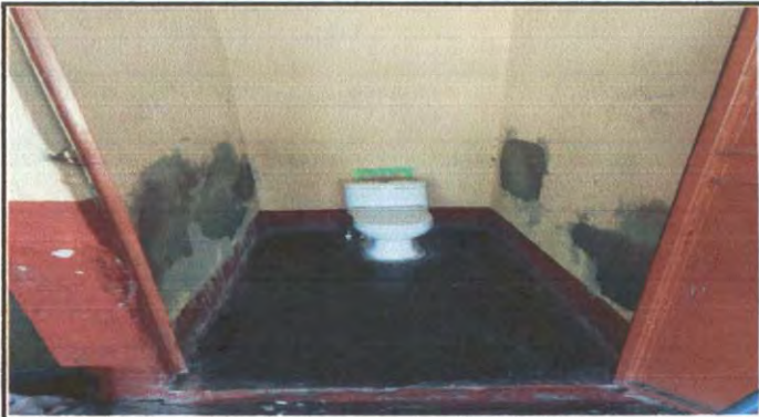
Foto 2: instalacion de baños para nivel pre-primaria
