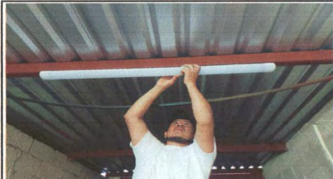
Foto 4: instalacion de lamparas
