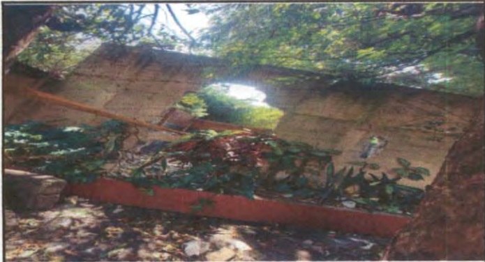
Foto1: inicio de la demolicion de la pared en mal estado
