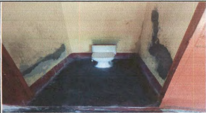
Foto1: instalacion de baños para nivel pre-primaria
