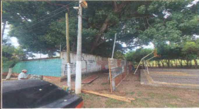
Foto 2: colocacion de cerco para proteccion antes del inicio de los trabajos
