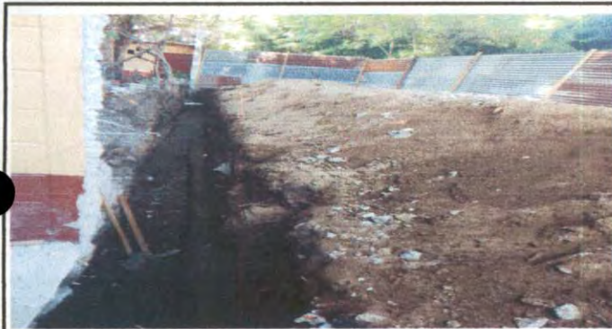
Foto 5: realizacion de la zanja
