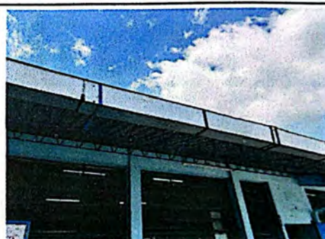
Foto 4: Suministro e instalación de tramo de canal pluvial
