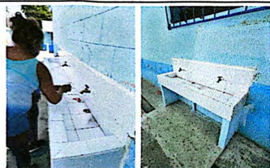
Foto 3: Fabricación de piletas tipo lavamanos forradas con azulejo.
