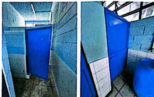
Foto 2: Mantenimiento de puertas metálicas en baños, incluye lijado y pintura.
