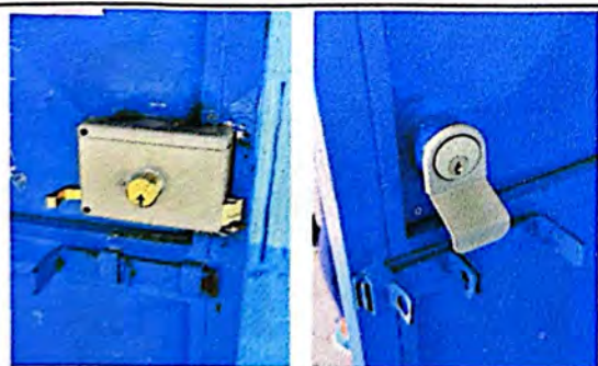
Foto 5: Suministro e instalación de chapa tipo yale.
