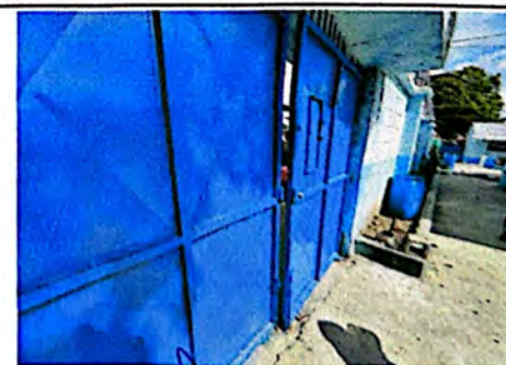
Foto 6: Mantenimiento a porton principal.
