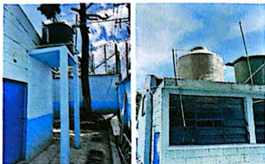
Foto 1: Fabricación de base para tinaco + suministro e instalación de tinaco nuevo para pileta.
