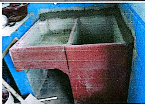
Foto 3: Suministro e instalación de pila.
