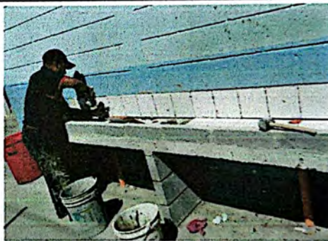
Foto 4: Proceso de fabricación de Pileta tipo lavamanos.
