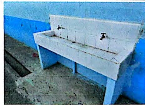
Foto 6: Suministro y fabricación de pileta tipo lavamanos.
