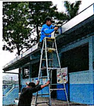
Foto 2: Suministro e instalación de piezas de canal pluvial + mantenimiento.
