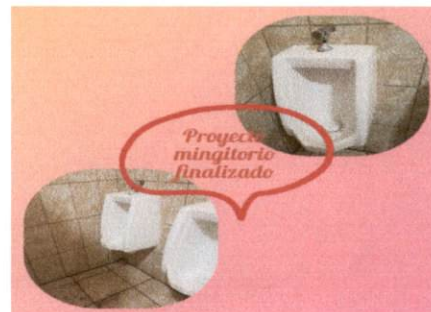
Foto 6: Sustitución de un mingitorio
