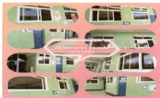
Foto 1: Área de sustitución de ventanas
