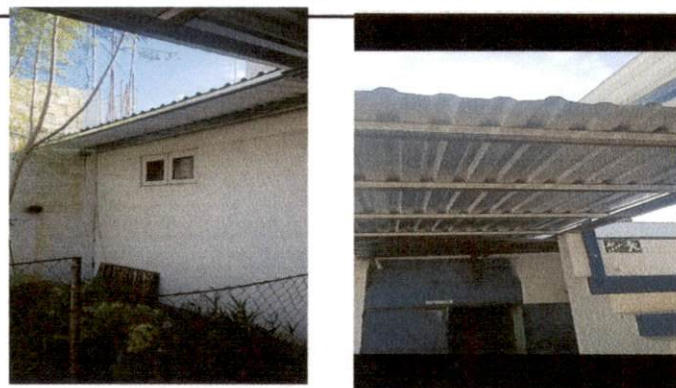
Foto 4: Ampliación de cubuerta y bajadas pluviales
