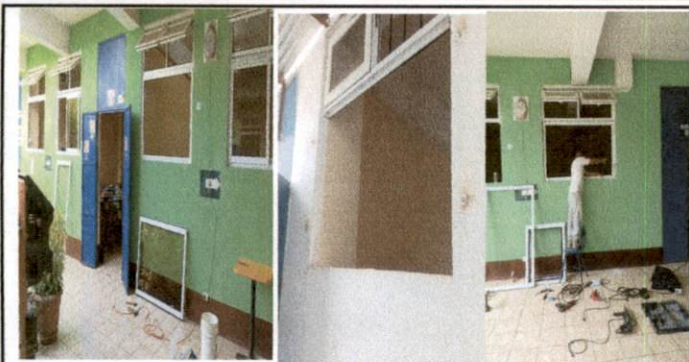
Foto 1.: Área de sustitución de ventanas
