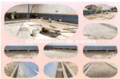
Foto 3.: Construcción de banca
