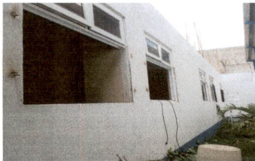
Foto 9. Colocación de balcones aula primer nivel
