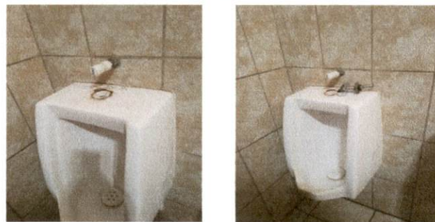
Foto 6.: Sustitución de un mingitorio
