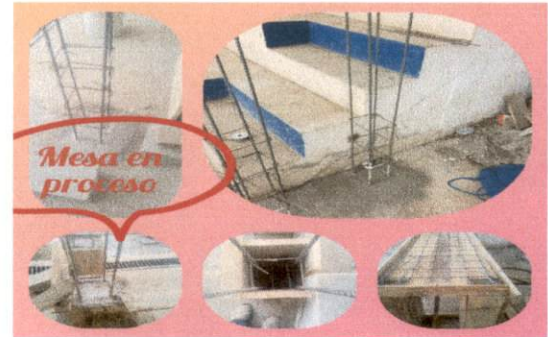
Foto 8. Construcción de mesa de tienda escolar
