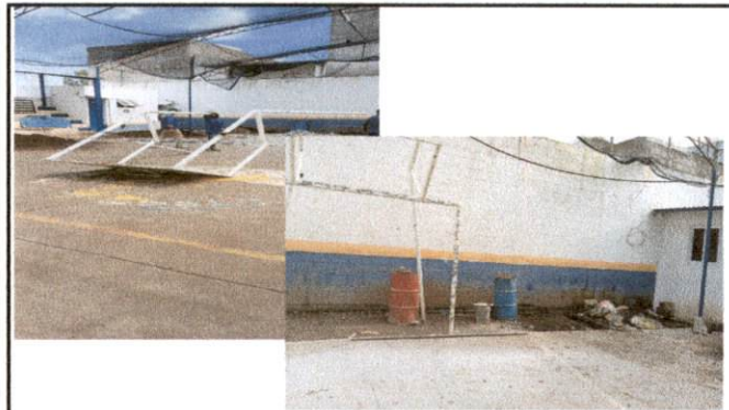
Foto 10. Reparación y modificación marco de porteria
