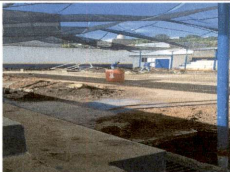
Foto 11. Construcción de escenario cancha polideportiva
