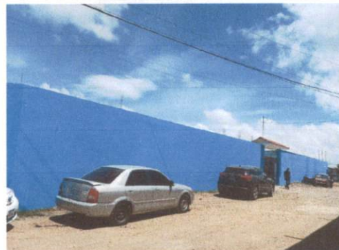
Foto 2: PINTURA DE MURO PERIMETRAL
