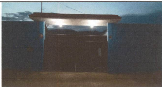
Foto 5: TERMINADA FACHADA DE ESCUELA
