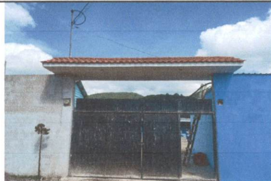
Foto 4: FACHADA DE ESCUELA
