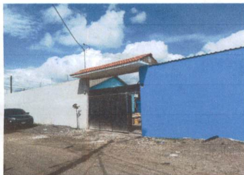
Foto 3: FACHADA DE LA ESCUELA
