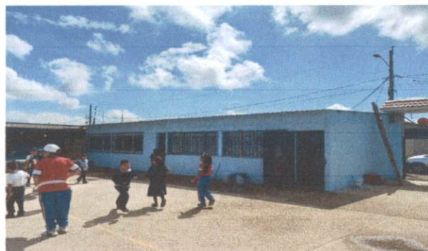
Foto 4: PINTURA DE DE SALON Y COCINA
