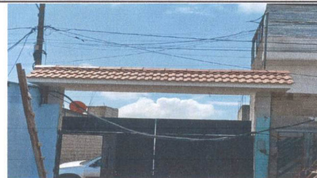
Foto 6: FACHADA DE ESCUELA
