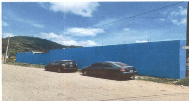
Foto 1: PINTURA DE MURO PERIMETRAL
