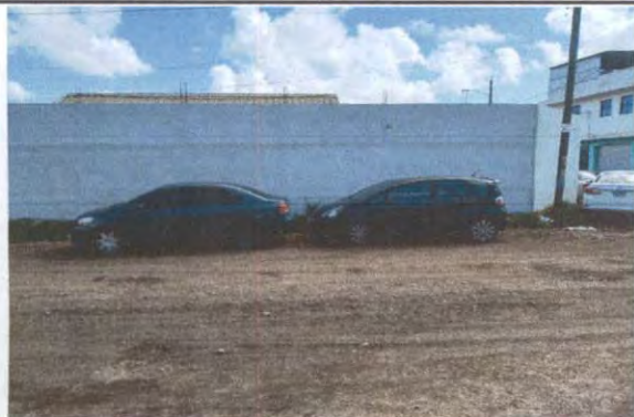
Foto 1: REPELLO DE MURO PERIMETRAL
