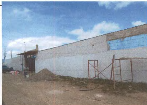
Foto 3: REPELLO DE MURO PERIMETRAL
