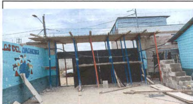
Foto 3: ARMazón DE FACHADA DE PORTÓN
