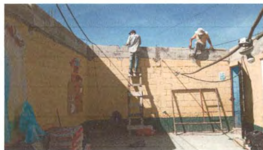
Foto 6: LEVANTADO DE 2 FILAS DE BLOK EN COSINA Y SALON
