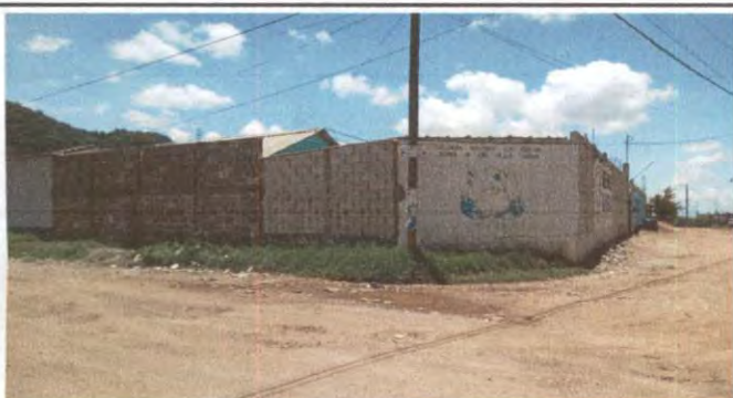
Foto 3: LEVANTADO DE MURO SOBRE MURO
