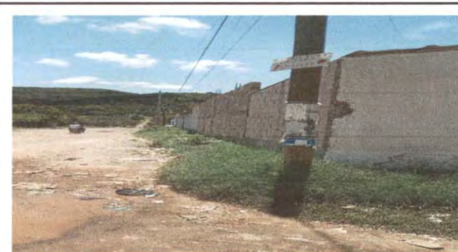
Foto 4: LEVANTADO DE MURO SOBRE MURO
