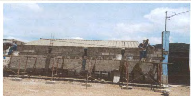
Foto 6: CONSTRUCCIÓN DE MURO SOBRE MURO
