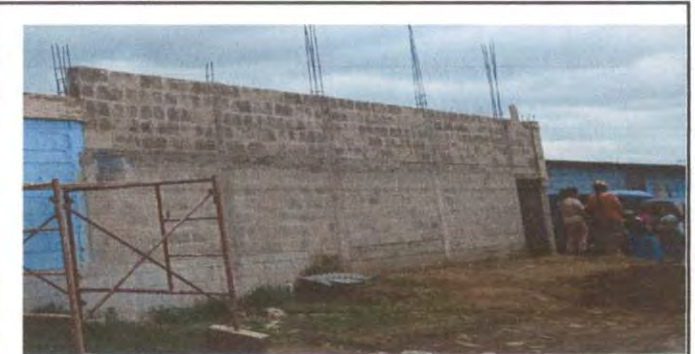
Foto 6: PARED CONSTRUIDA MURO SOBRE MURO
