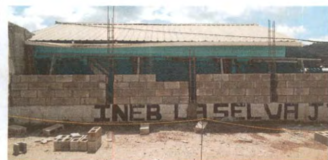
Foto 5: CONSTRUCCIÓN DE MURO SOBRE MURO
