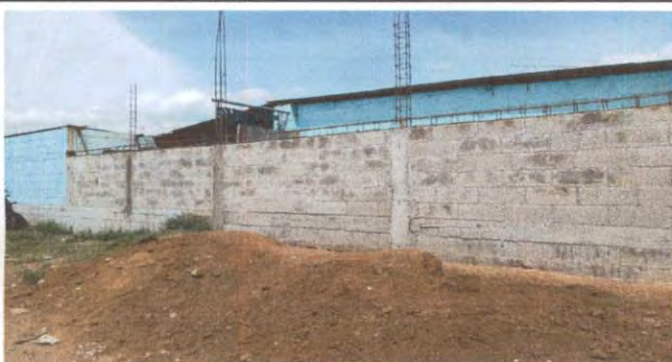
Foto 3: LEVANTAMIENTO DE MURO SOBRE MURO
