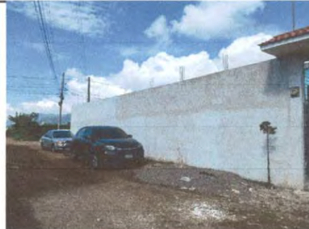
Foto 2: REPELLO DE MURO PERIMETRAL
