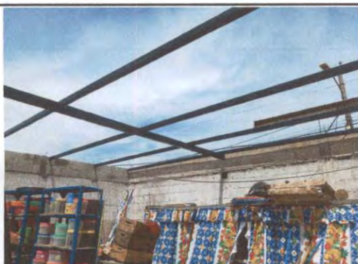
Foto 3: COLOCACION DE COSTANERAS QUE SE DIO MANTENIMIENTO
