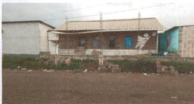
Foto 1: LEVANTADO DE MURO SOBRE MURO *
