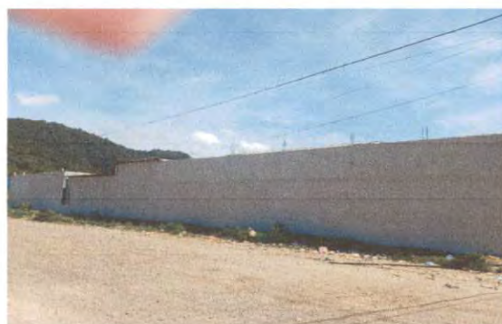
Foto 4: REPELLO DE MURO PERIMETRAL
