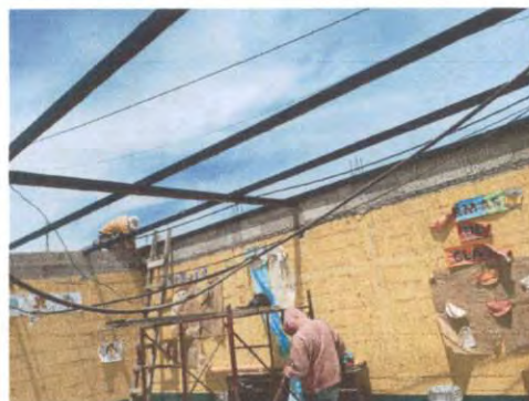
Foto 4: COLOCACION DE COSTANERAS QUE SE DIO MANTENIMIENTO
