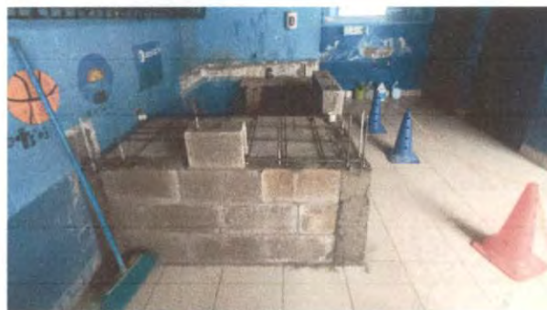
Foto 2: PILETA EN CONSTRUCCIÓN
