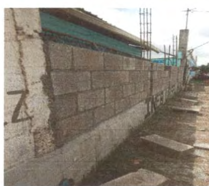
Foto 4: CONSTRUCCIÓN DE MURO SOBRE MURO
