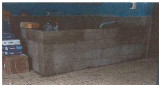
Foto 4: PILETA EN CONSTRUCCIÓN
