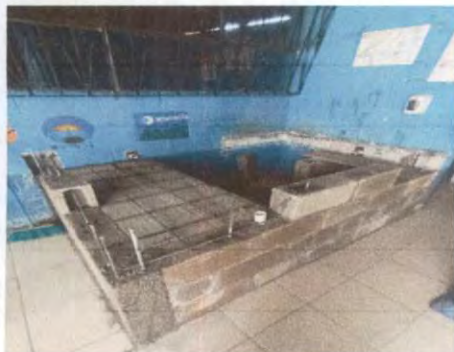
Foto 1: PILETA EN CONSTRUCCIÓN
