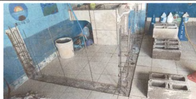
Foto 6: CONSTRUCCIÓN DE PILETA
