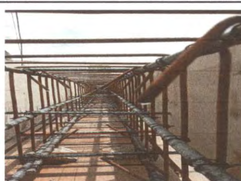
Foto 4: ARMazón DE FACHADA DE PORTÓN
