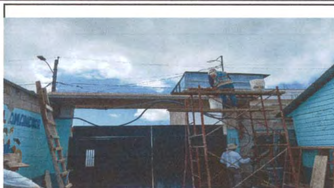
Foto 2: ARMazón DE FACHADA DE PORTÓN
