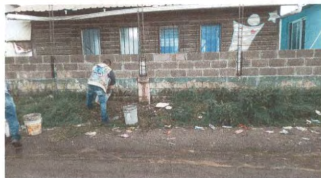
Foto 2: LEVANTADO DE MURO SOBRE MURO
