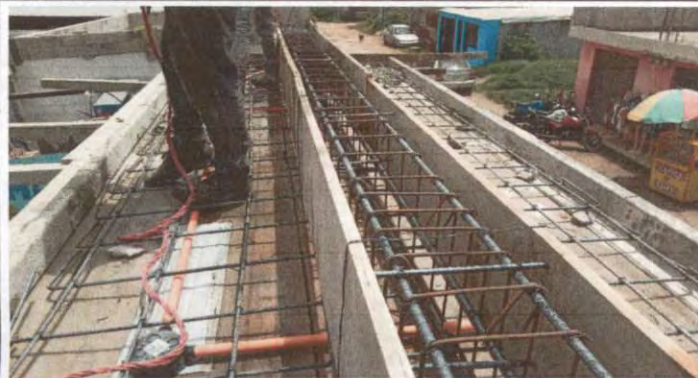
Foto 1: ARMazón DE FACHADA DE PORTÓN
