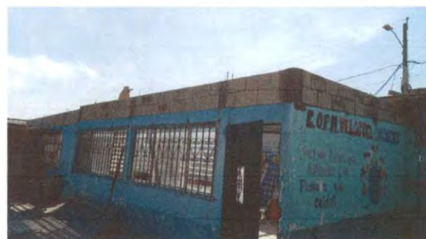
Foto 6: LEVANTADO DE DOS FILAS PARA COCINA
