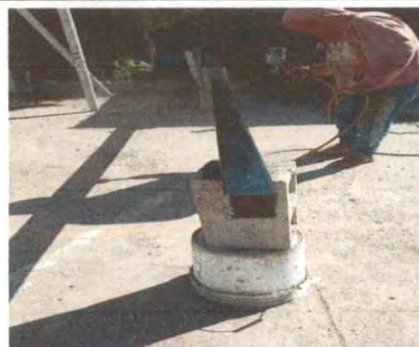
Foto 6: MANTENIMIENTO DE COSTANERAS
