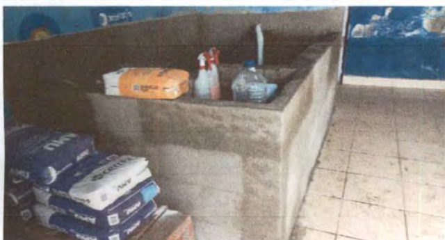
Foto 3: PILETA EN CONSTRUCCIÓN
