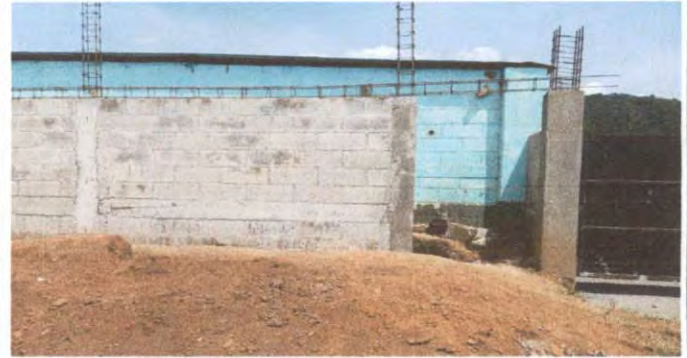
Foto 2: CONSTRUCCIÓN DE BASURERO
