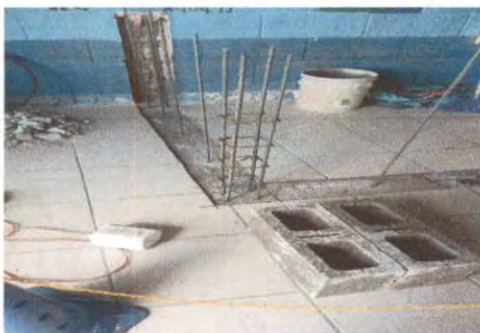
Foto 5: CONSTRUCCIÓN DE PILETA
