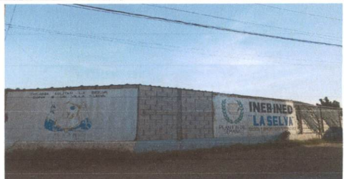
Foto 6: REPELLO Y LEVANTADO DE DOS FILAS DE BLOCK
