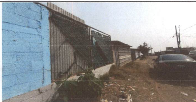
Foto 3: CONSTRUCCIÓN DE MURO SOBRE MURO
