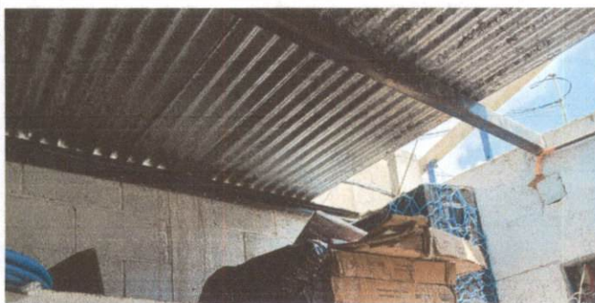
Foto 5: CAMBIO DE LÁMINA DE COCINA
