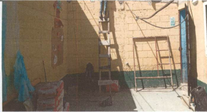
Foto1: LEVANTADO DE DOS FILAS DE BLOCK REPELLO DE SALÓN
