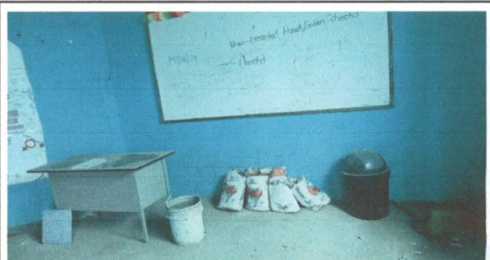
Foto 2 COLOCACIÓN DE PISO
