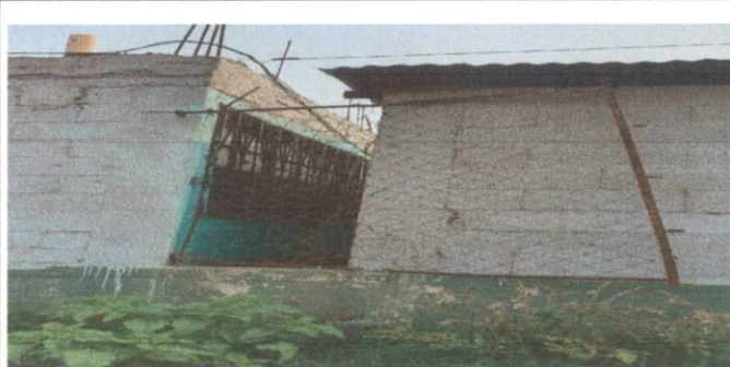
Foto 2: CONSTRUCCIÓN DE MURO SOBRE MURO
