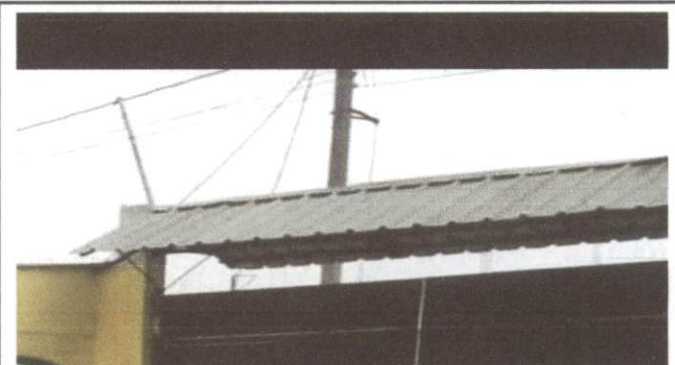
Foto 4: REPARACIÓN DE FACHADA DE PORTÓN
