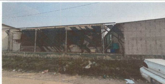
Foto 1: CONSTRUCCIÓN DE MURO SOBRE MURO
