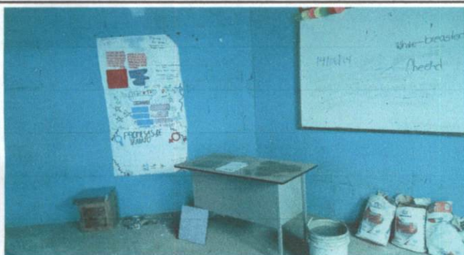
Foto 3: PREPARACIÓN DE MATERIAL PARA COLOCACION DE PISO
