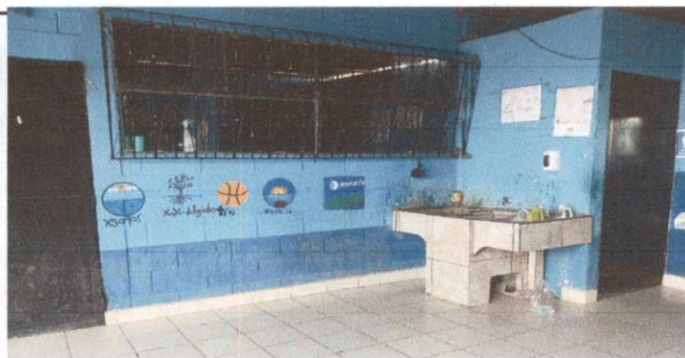
Foto 5: PILA DE 3 LAVADEROS
