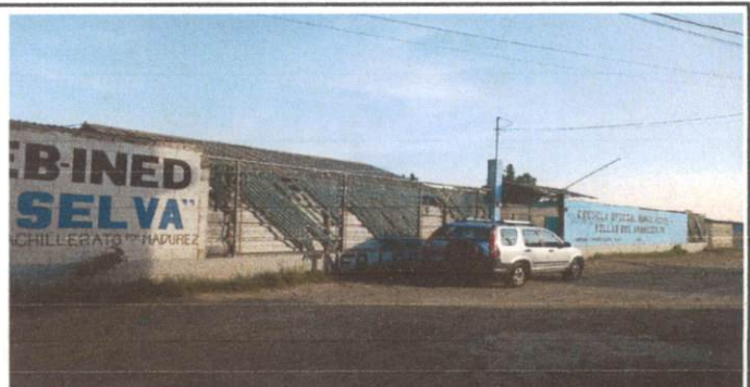
Foto 4: CONSTRUCCIÓN DE MURO SOBRE MURO
