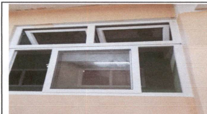
Apertura de espacios para ventanas
