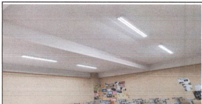
Mejoramiento del sistema eléctrico
