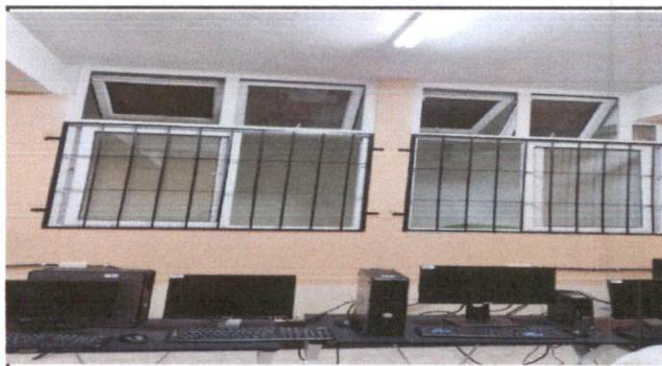
Apertura de espacios para ventanas
