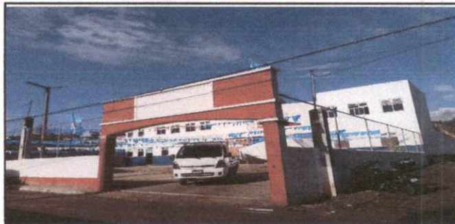
Complemento de pared y colocación de malla en muro perimetral
