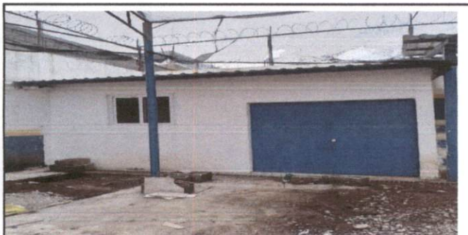
Adecuación de bodega
