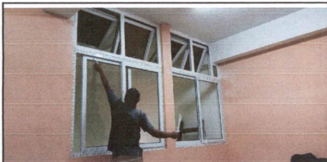
Apertura de espacios para ventanas
