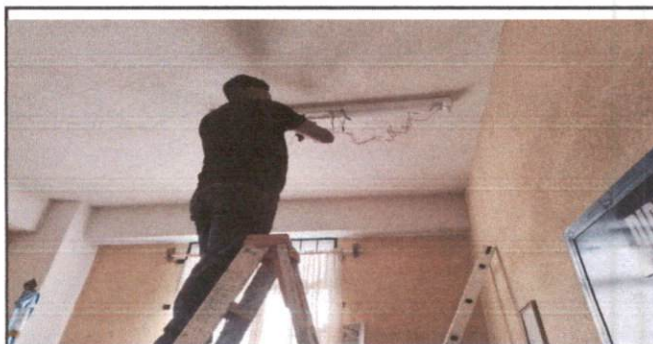
Mejoramiento del sistema eléctrico
