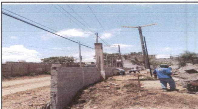
Complemento de pared y colocación de malla en muro perimetral
