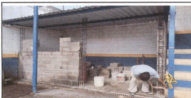
Adecuación de bodega
