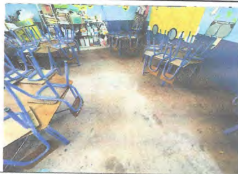
Foto 4: Modulo 1, se colocara piso ceramico en aulas
