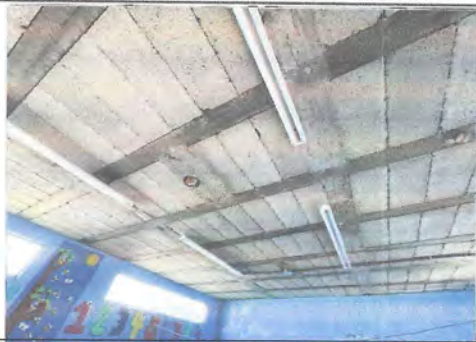
Foto 5: Se aplicara repello en cielo de aulas
