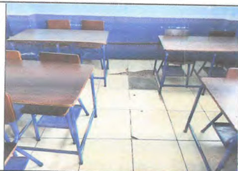
Foto 11: Se sustituirá el piso cerámico y se aplicará pintura en muros
