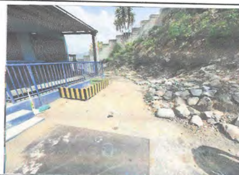
Foto 10: Se colocará piso de concreto para evitar la humedad en el módulo 1
