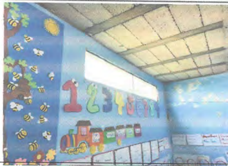
Foto 6: Se sustituiran ventanas por Ventanas de PVC
