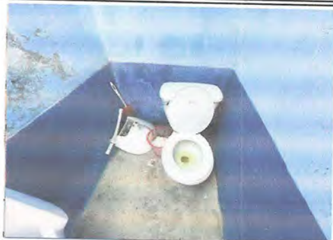
Foto 7: Se sustituirá sanitario, se colocará piso cerámico y azulejo
