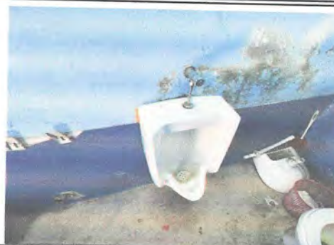
Foto 8: Se sustituirá mingitorio y se colocará piso cerámico y azulejo
