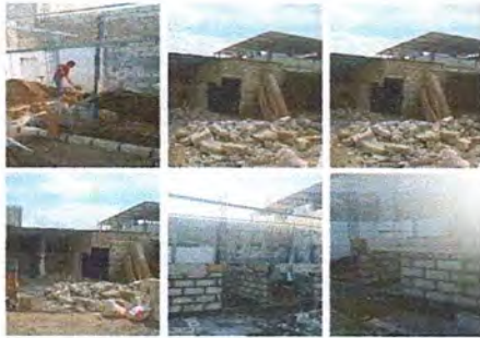
Foto: 1 DEMOLICIÓN DE SANITARIOS Y RECONSTRUCCIÓN
