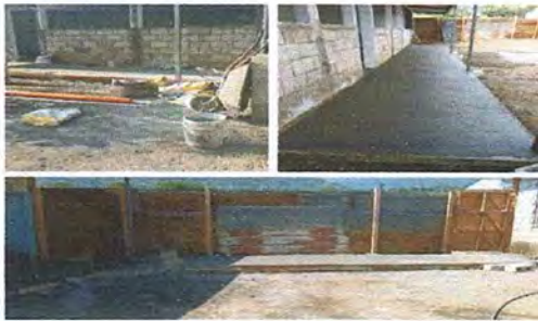
Foto: 3 CORREDOR Y CAMINO
