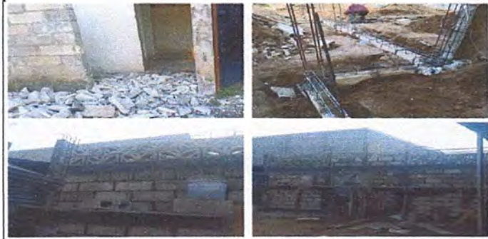
Foto: 4 DEMOLICIÓN DE PARED Y AMPLIACIÓN DE SALON
