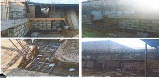
Foto: 1 DEMOLICIÓN DE SANITARIOS Y RECONSTRUCCIÓN
