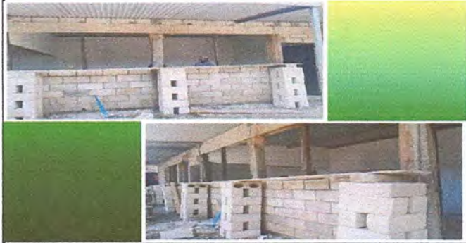
Foto: 2 INSTALACIÓN DE VIGA LINEAL
