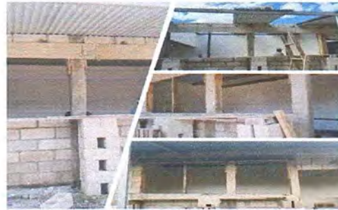
Foto: 2 INSTALACIÓN DE VIGA LINEAL
