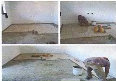
REMOZAMIENTO DE SALON, PISO Y REPELLO
