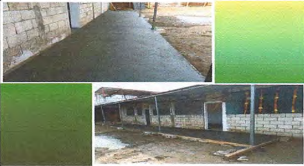
Foto: 3 CORREDOR Y CAMINO
