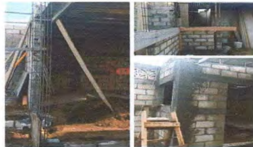
Foto: 4 DEMOLICIÓN DE PARED Y AMPLIACIÓN DE SALON
