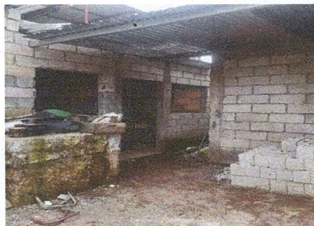
Foto: 4 DEMOLICIÓN DE PARED Y AMPLIACIÓN DE SALON
