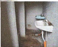
Foto: 1 DEMOLICIÓN DE SANITARIOS Y RECONSTRUCCIÓN
