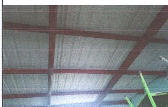
Foto 4: colocación de lamina terminada
