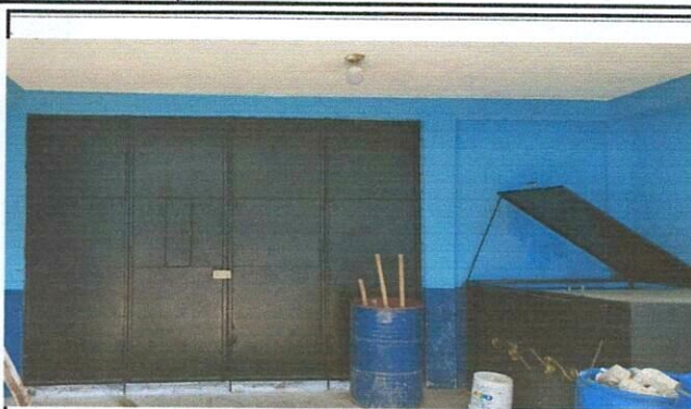
Foto 8: porton ,columna y pared terminados
