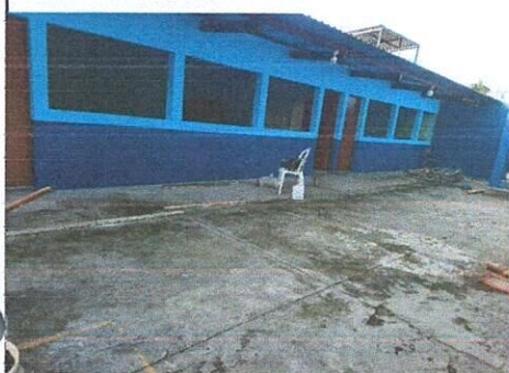
Foto1: pintura exterior de salones terminado
