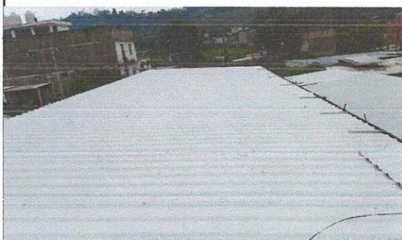
Foto 3: colocación de lamina terminada
