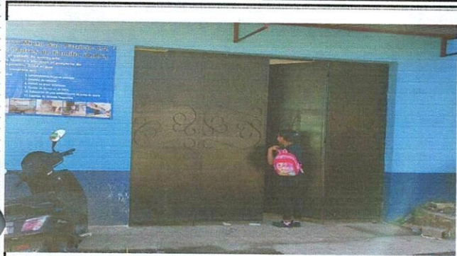
Foto 7: porton ,columna y pared terminados
