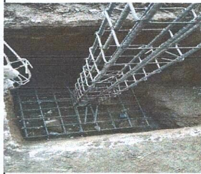
Foto 2: roceso de la columna de refuerzo
