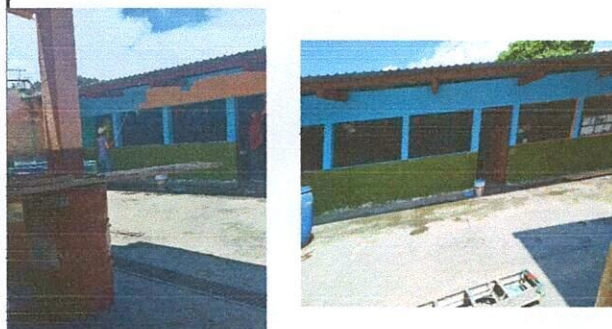
Foto 5: proceso de pintura
