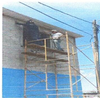
Foto 10: colocacion de balcones
