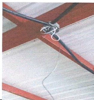
Foto 8: cambio en el sistema eléctrico
