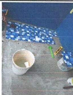
Foto 9: colocacion del piso antideslizante
