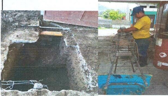
Foto1: proceso de elaboración de columna y pared
