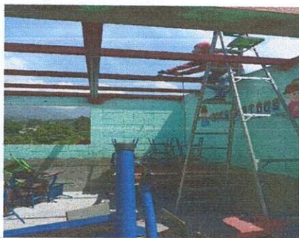
Foto 7: cambio de lámina
