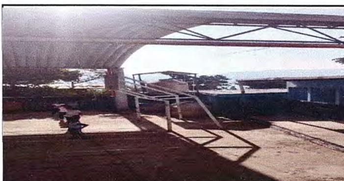
reparacion de techo de rotoplast
