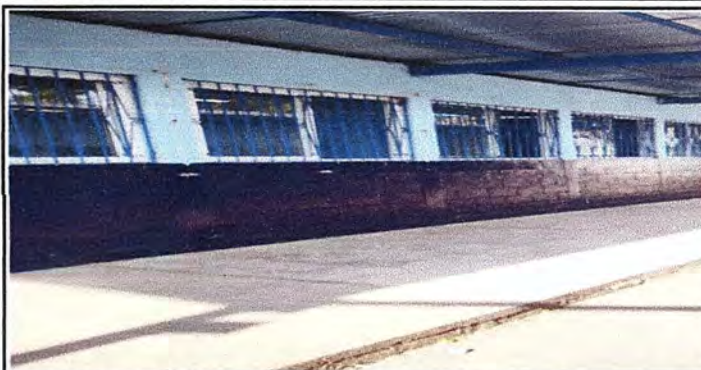
instalacion de balcones
