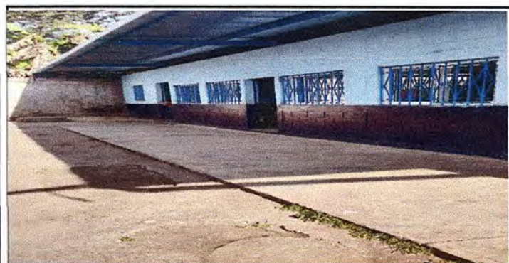
intalacion de ventanas
