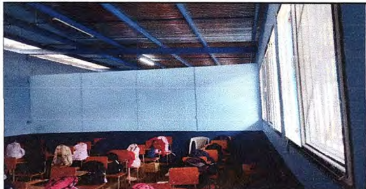
reparacion de division y pintura de salones
