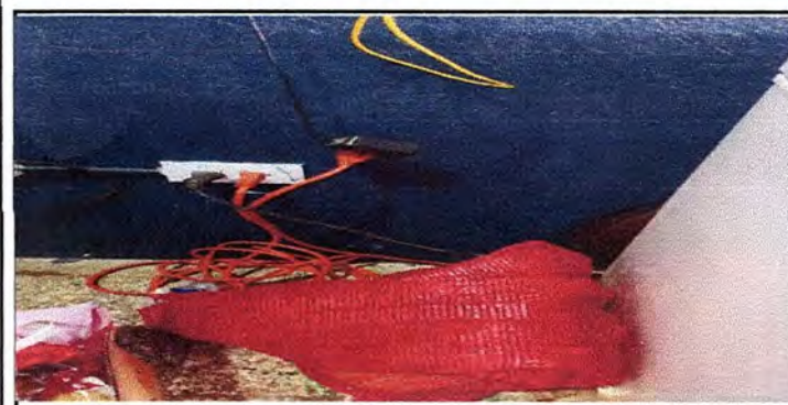
instalacion de tomacorrientes
