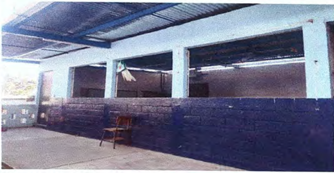
retiro de ventanas y balcones
