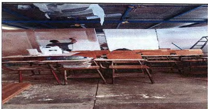
reparacion de division de salones
