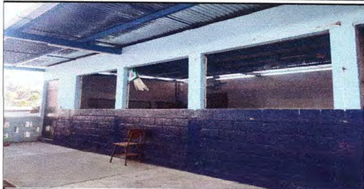
retiro de venstanas y balcones
