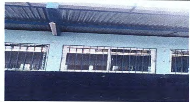
instalacion de balcones
