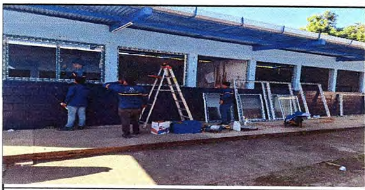
instalacion de ventanas
