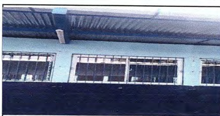
instalacion de balcones
