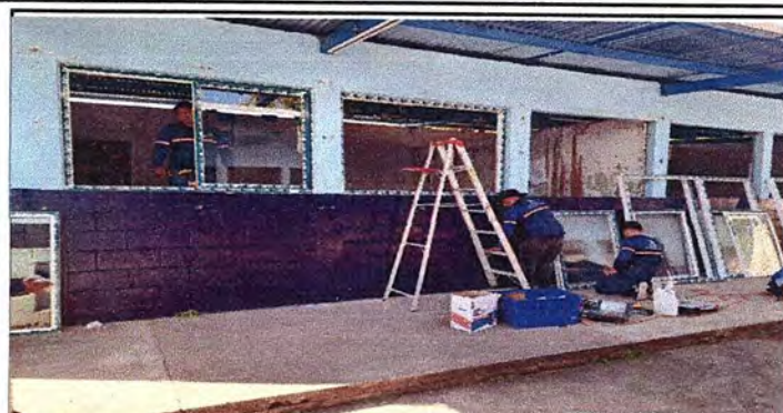
instalacion de ventanas
