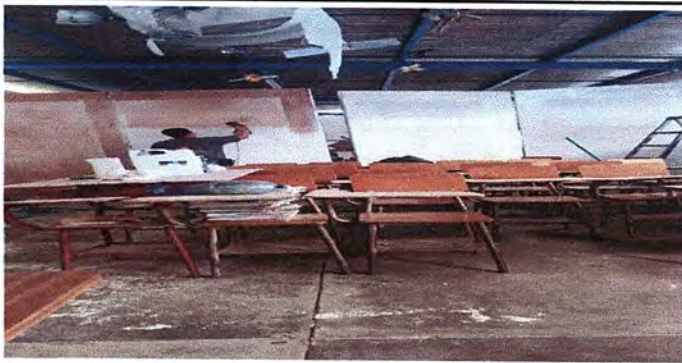
reparacion de division de salones
