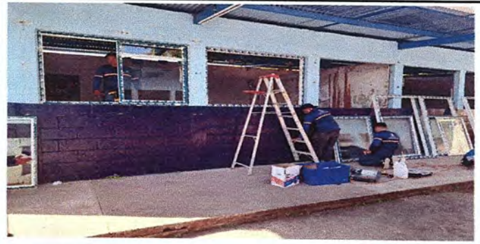
instalacion de ventanas
