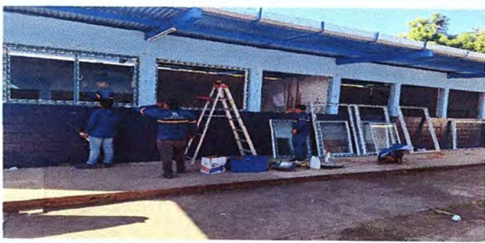
instalacion de ventanas
