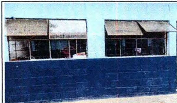
Foto: 6 ACONDICIONAMIENTO DE COCINA
