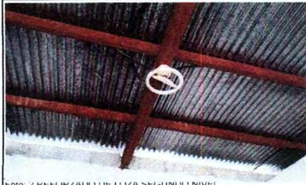
Foto: 2 REFORZADO DE LOZA SEGUNDO NIVEL
