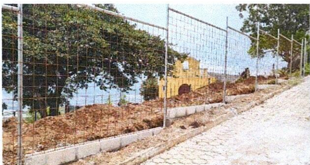
Foto1: MALLA PERIMETRAL COLOCADA
