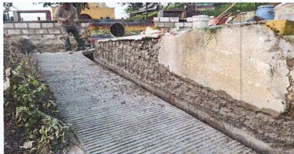
Foto 2: RAMPA YA TERMINADA
