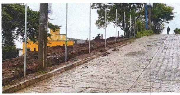
Foto 6: COLOCACIÓN DE DE POSTES PARA COLOCAR MALLA
