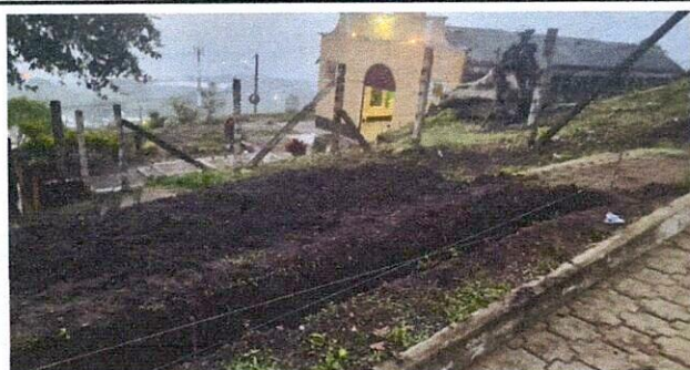
Foto 3: ZANJEO PARA COLOCAR MALLA
