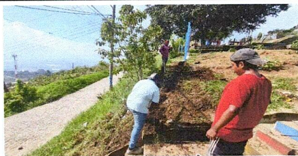
Foto 5: ZANJEO PARA COLOCAR MALLA
