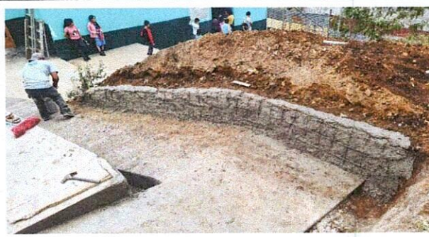
Foto 4: RAMPA PARA ACCESO PRINCIPAL
