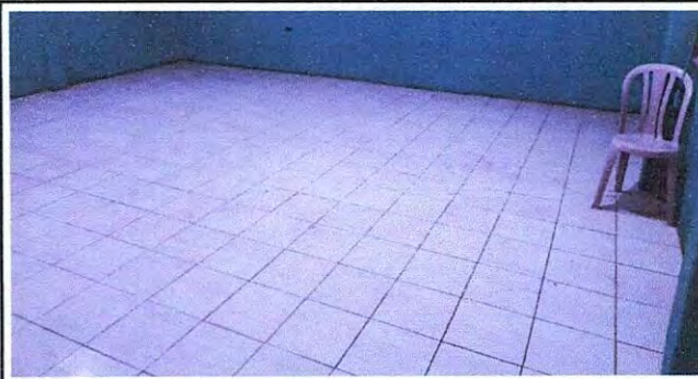
Foto 2: Piso de salón 1ro.B Finalizado de instalar
