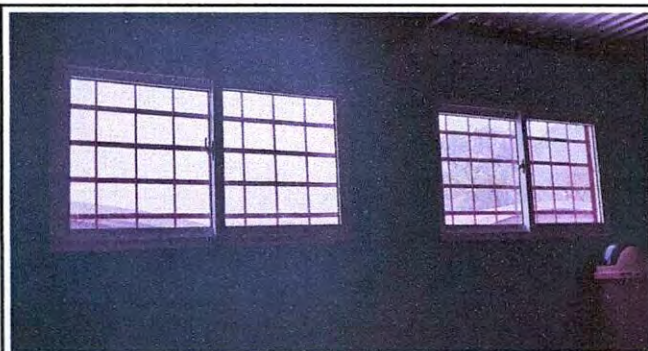
Foto 3: Balcones y ventanas terminadas 4to.A
